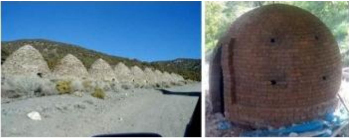
Ilustración 1-21 Diferentes tipos de horno de ladrillo: colmena (izquierda) y media naranja (derecha)
