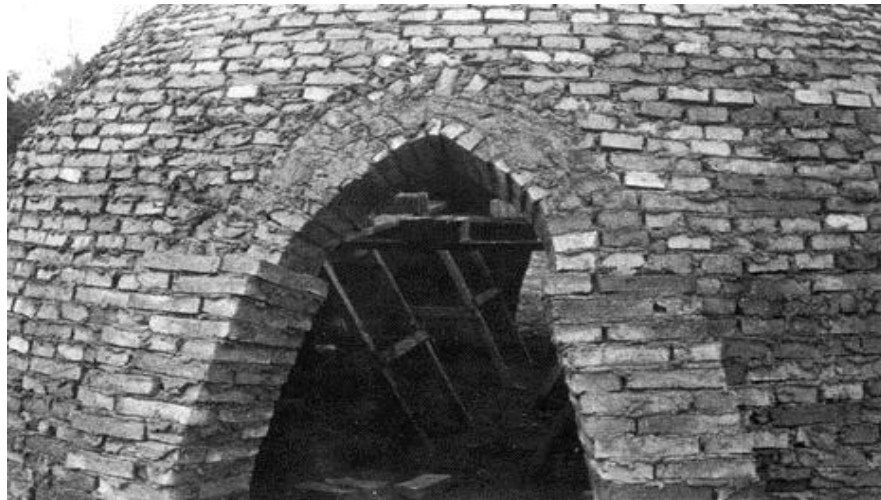
Ilustración 1-23 Una carbonera media naranja apenas terminada
