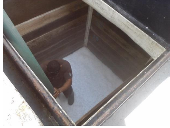
Bodega de enfriamiento
