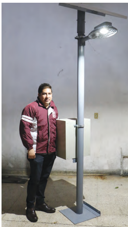
Las luminarias creadas por Manuel Parra han mostrado su eficiencia y ahorro de energía en temperaturas extremas de calor y frío (Foto: Adalberto Solís)
