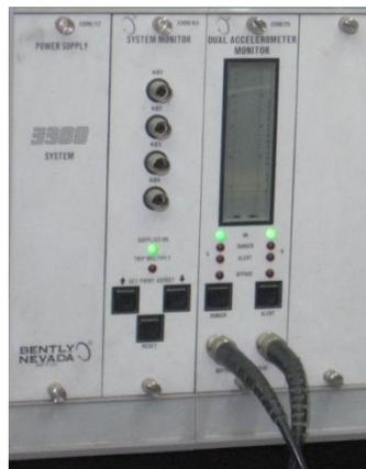
fig 3. 14 Modulo de interface Adre-Acondicionador modelo 3300 Bently Nevada ®
