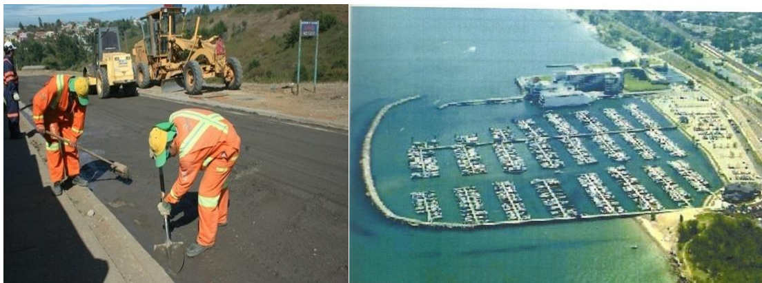
Figura 3. Ejemplos de aplicación de las escorias. La figura de la derecha muestra el rompeolas construido con escoria de alto horno en el lago Michigan
