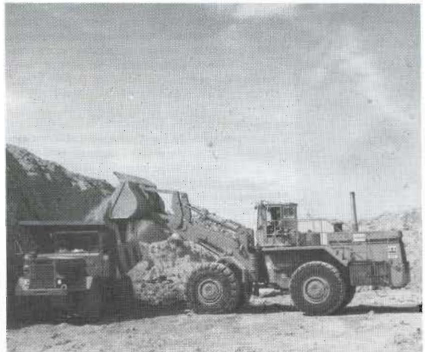
Carga, aquí se muestra la limpieza del terreno realizado por un cargador frontal sobre neumáticos terex 90 C y un euclid 20. Foto: Felipe Longoria.
