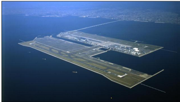
Figura 7. Aeropuerto Internacional de Kansai. Está ubicado en una isla artificial de 4 km de largo por 1 km de ancho, en la bahía de Osaka, Japón. Fue diseñado por el arquitecto Renzo Piano, inaugurado el 4 de septiembre de 1994.
