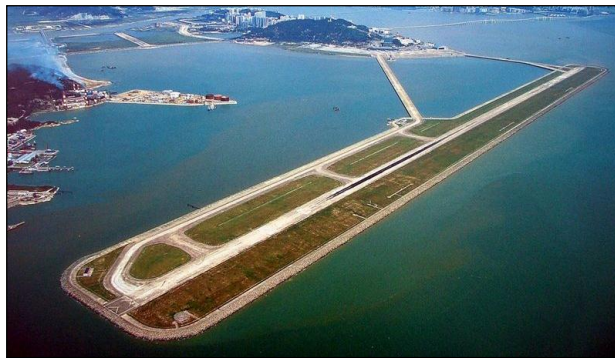
Figura 10. Aeropuerto Internacional de Macao. Construido sobre una isla artificial situada en el extremo oriental de la isla de Taipa, sus operaciones iniciaron en noviembre de 1995.
