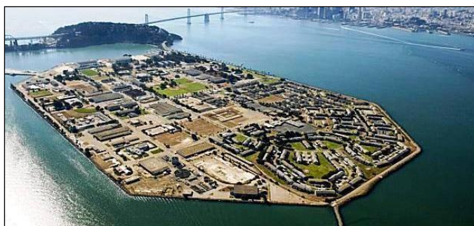
Figura 19. Isla Treasure. Construida en la Bahía de San Francisco, California, EUA. Fue creada a partir del llenado del material procedente del dragado de la Bahía en los años 1936 y 1937.
