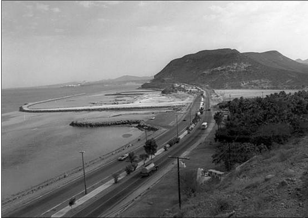
Figura 34. Construcción de la Marina Palmira y el desplante para la construcción del Hotel Marina (1988). En la imagen también se puede apreciar el terraplén donde hoy en día se encuentran los negocios de cocos y su estacionamiento. Formado con roca de la región (riolita), al igual que el rompeolas de la Marina La Paz.
