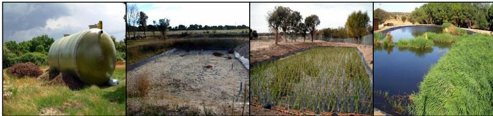
Figura 9. EDAR de Monleras, España. De izquierda a derecha: Tanque Imhoff, humedal de flujo subsuperficial vertical, humedal de macrófitos en flotación y humedal artificial.
