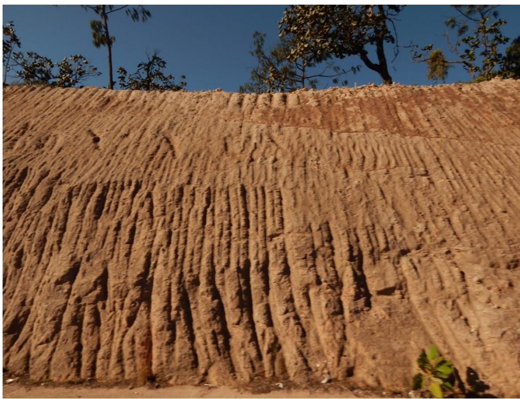
Vista actual de los taludes
