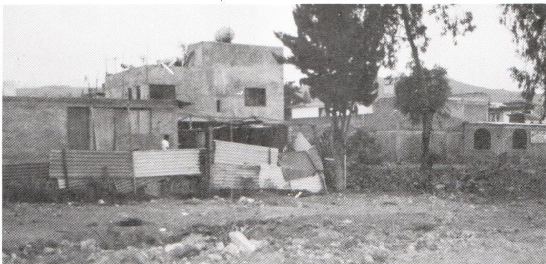
Construcciones en forma progresiva y sin asistencia técnica. Foto: Archivo.
