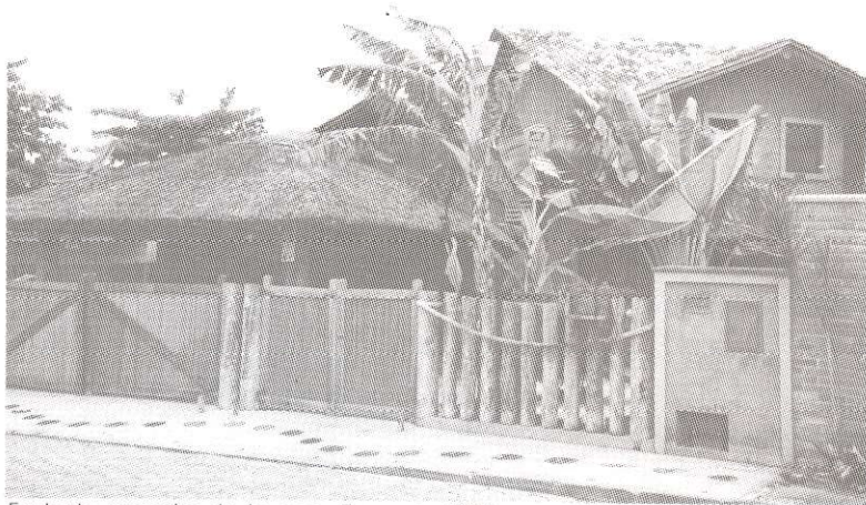
Fachada posterior de la casa. Enero de 2000.
