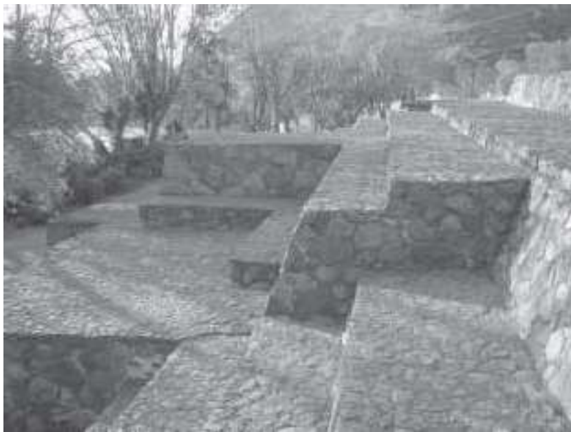
Construcción de tableros con un sistema constructivo de estuco coloreado.
