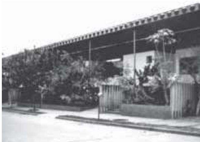
Acceso al edificio.
