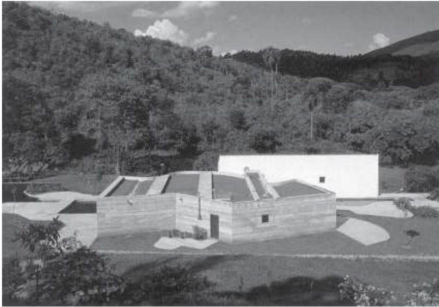
Casa de sitio, Cabreúva, 1997. Vista aérea del conjunto.
