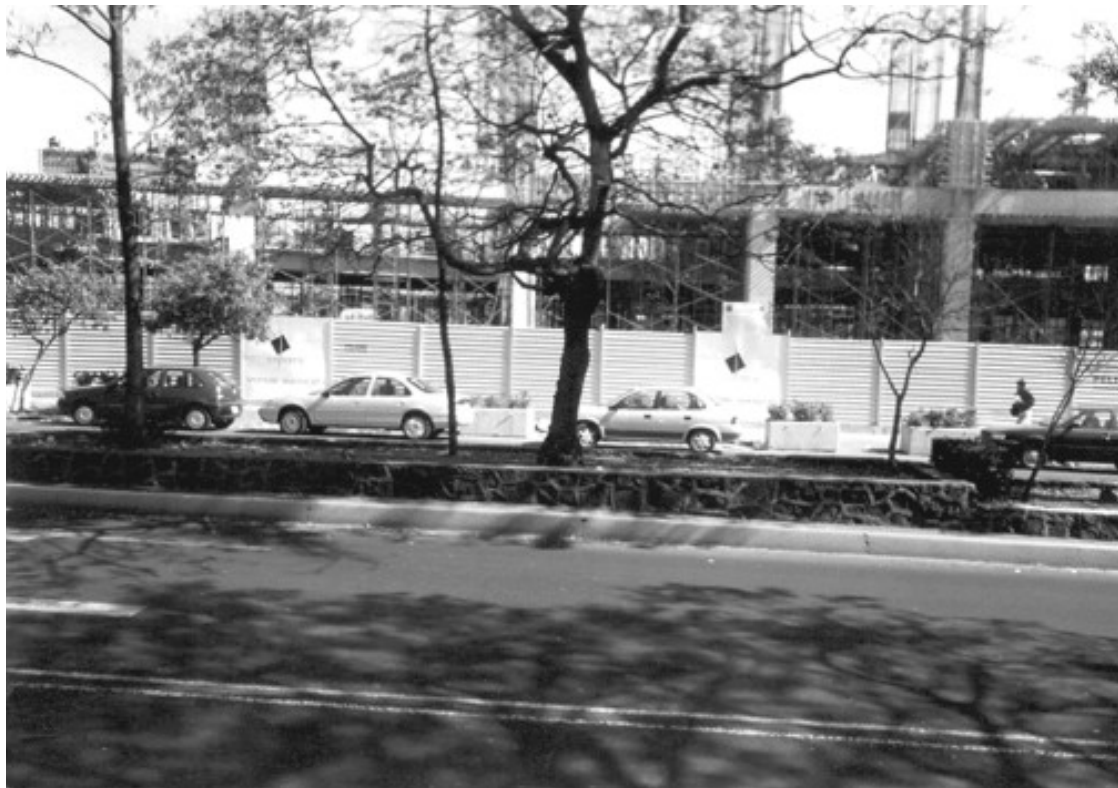
Construcción del corporativo de oficinas Antara Polanco, sobre Av. Ejército Nacional (2003).
