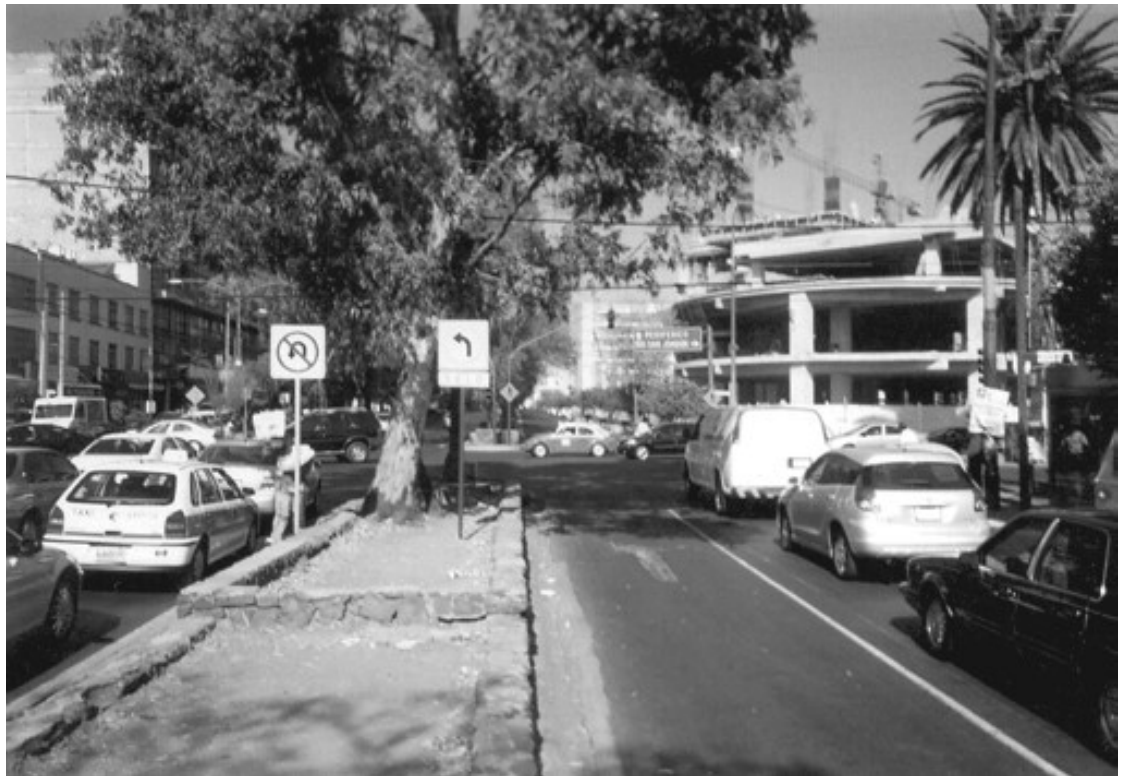
Construcción del conjunto Antara Polanco, cruce de Molière y Av. Ejército Nacional, antes de construir deprimido vial en 2003.
