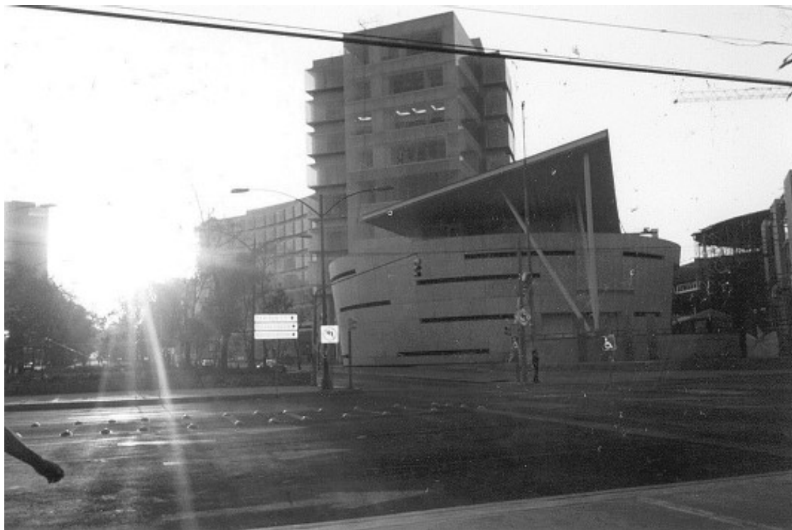
Vista exterior del conjunto Antara Polanco y deprimido vial, cruce de Av. Ejército y Molière (2005).
