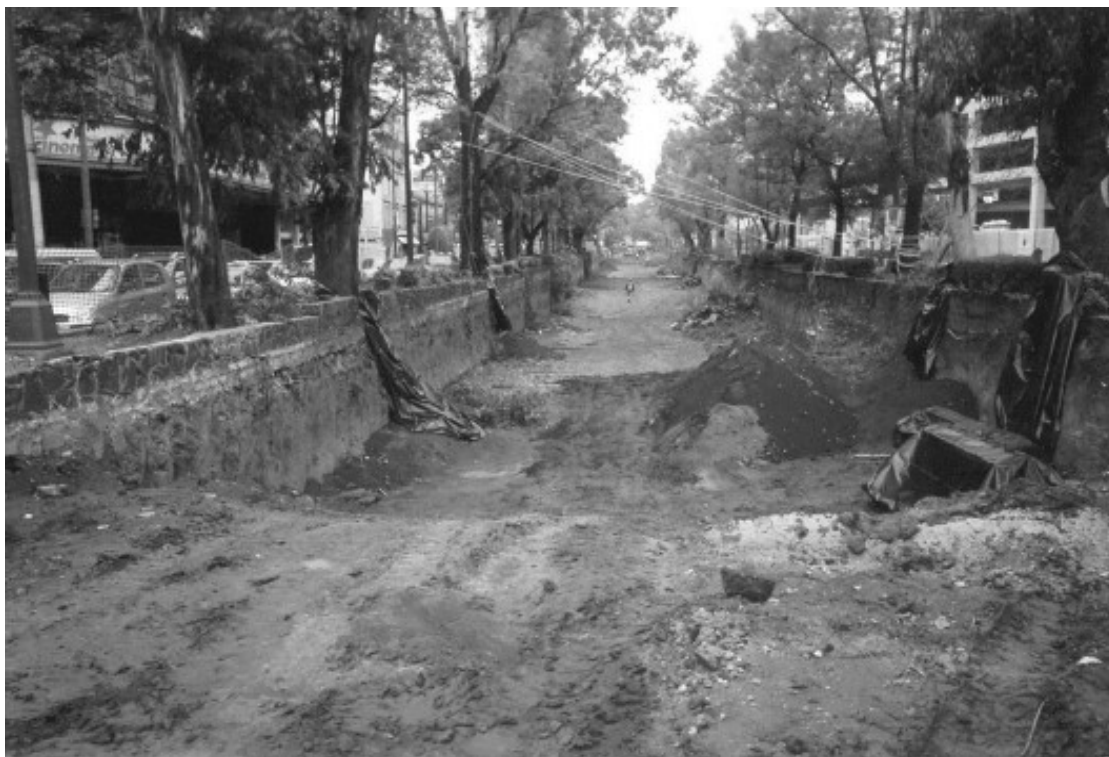
Modificación de los cuatro carriles centrales de Av. Ejército Nacional por la construcción, en 2005, de un deprimido vial.
