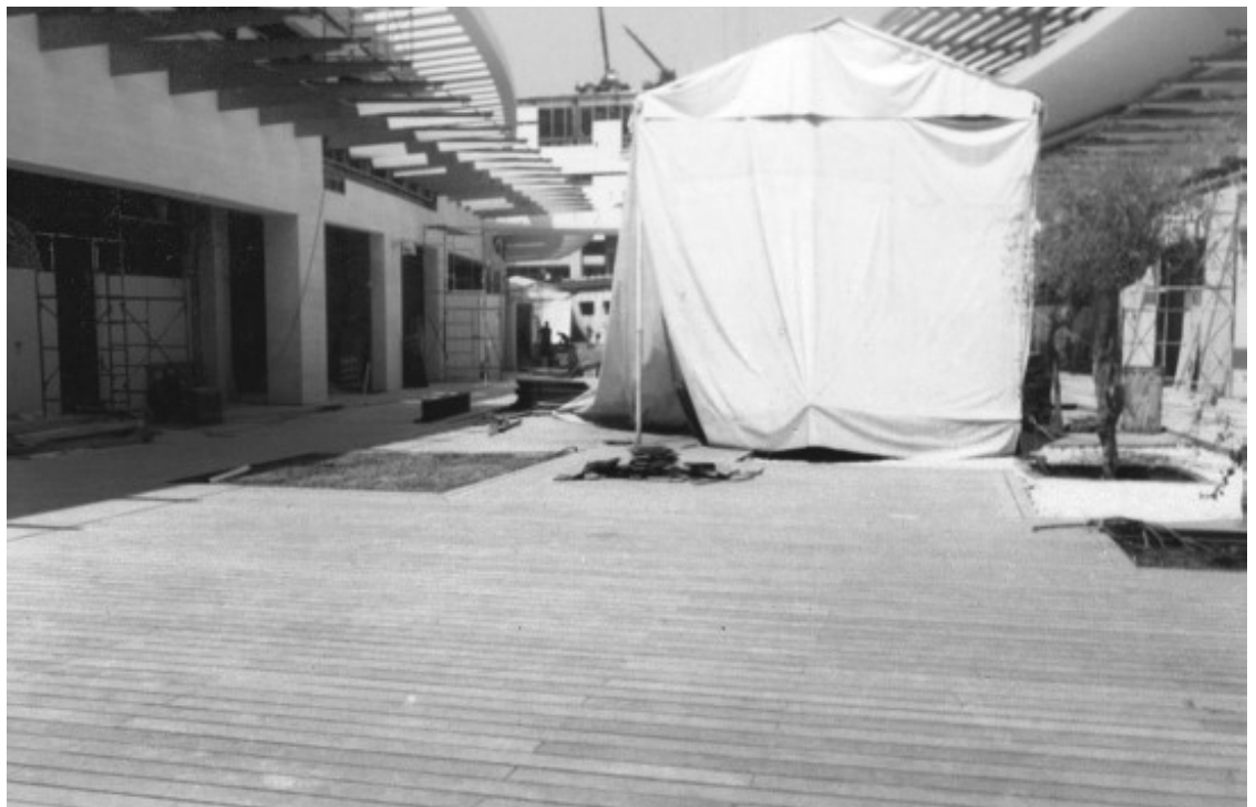
Vista oriente de la Plaza Paseo y en construcción casa Palacio (2005).
