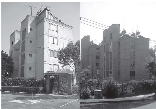
Foto 3: Falta de apropiación en los calentadores solares, Conjunto Pedregal Imán, Ciudad de México, 2009.
