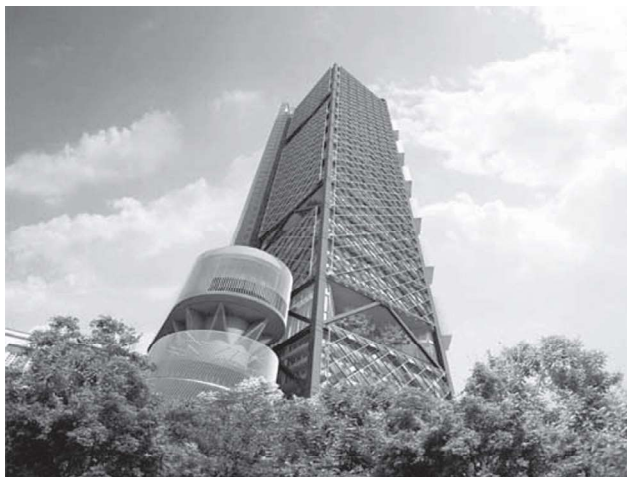
Vista exterior de la Torre Ejecutiva BBVA Bancomer.
