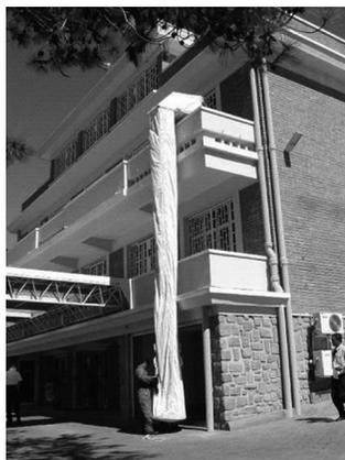
Figura 6. Sistema de evacuación modular deslizable.
