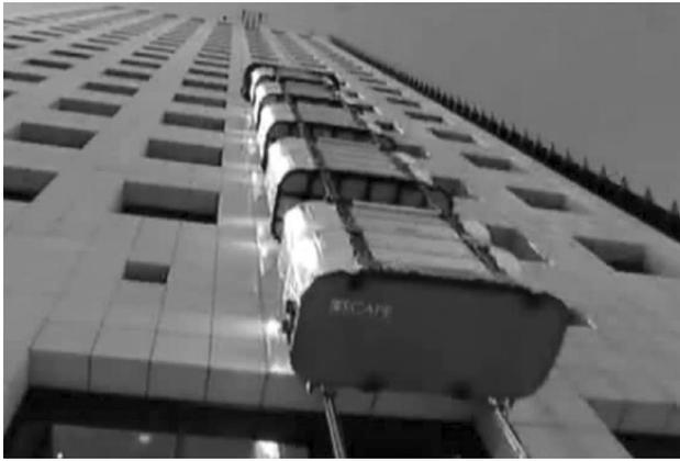
Figura 3. Edificio con elevadores exteriores para evacuación.
