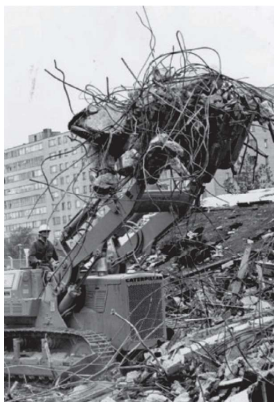
Bulldozer entre escombros de hormigón roto y varillas de acero de refuerzo, 24 de octubre de 1972. Jack January Fuente: http://stltoday.mycapture.com/mycapture/folder.asp?event=1045829&CategoryID=48250&ListSubAlbums=0
