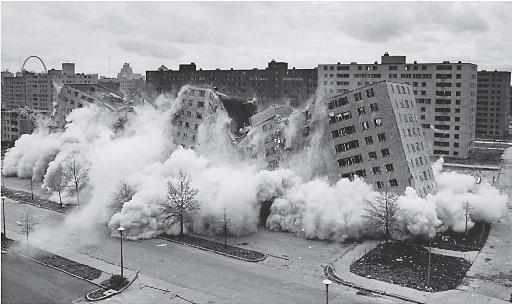
Demolición de Pruitt-Igoe, 1972.
