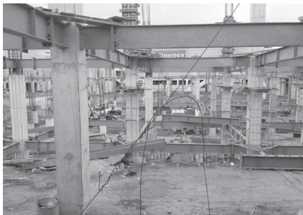
Fotografía 2. Construcción de grandes centros comerciales. Ampliación del Centro Comercial Mundo E en Tlalnepantla, Estado de México.
