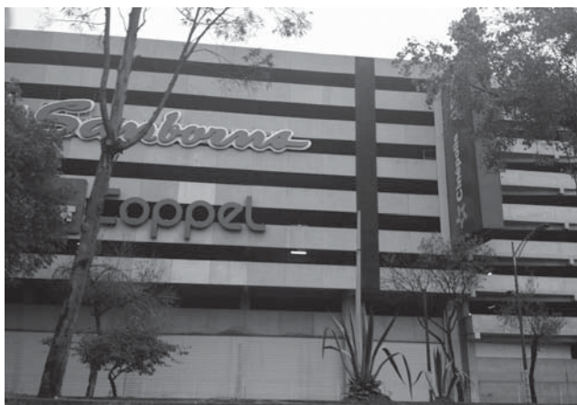
Fotografía 4. Las tiendas anclas son representadas desde el exterior. centro comercial Fórum ubicado en Insurgentes. Fotografía: MGVV, 2015.
