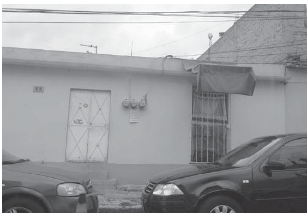
Fotografía 13. Viviendas aledañas al centro comercial se venden para la construcción de edificios, San Lucas Tepetlalcusco en Tlalnepantla, cerca de Mundo E. Fuente: MGVV, 2015.
