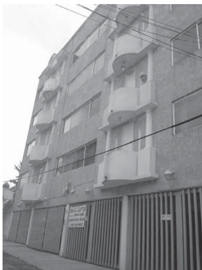
Fotografía 17. Desarrollo de edificio de departamentos de empresas inmobiliarias cercanos al centro comercial Mundo E. San Lucas Tepetlalcálco, Tlalnepantla Estado de México. Fuente: MGVV, 2015.
