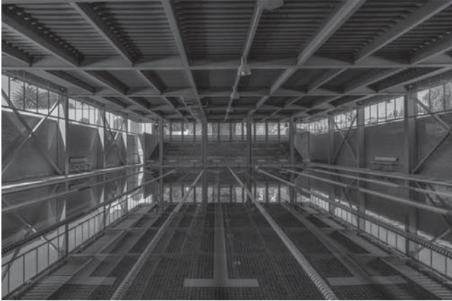
Figura 3. CEBJ, piscina techada.
