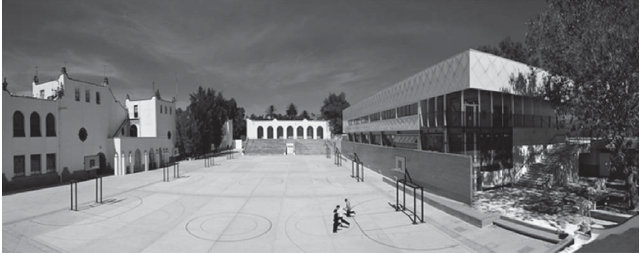
Figura 4. CEBJ, patio interno posterior.
