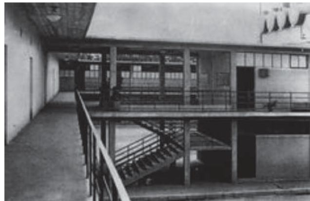
Figura 9. Escuela Emiliano Zapata. Escaleras en forma de U con los sanitarios.
