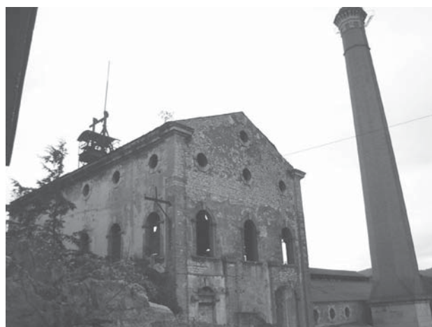
Casas de máquinas, Mina Dificultad.
