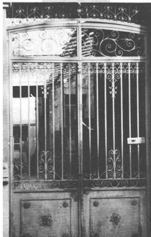
Espacios que pueden revivir tras una restauración
