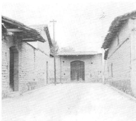
Conjunto de casas de adobe en una comunidad del Estado de México.
