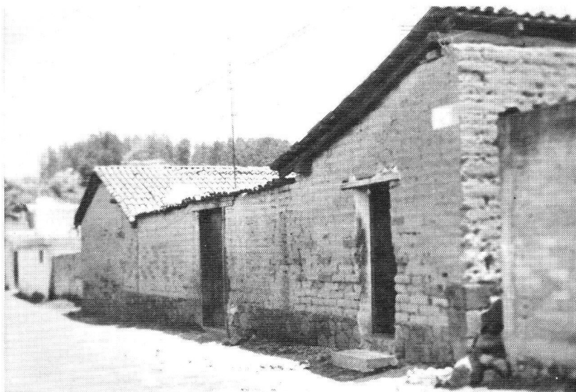
La sencillez de las fachadas genera la belleza que Barragán explotó.
