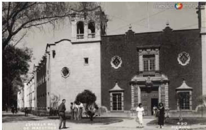
El edificio de la Escuela Nacional de Maestros conocido como “Santo Tomás” (imagen: México en fotos , consultado en línea).
