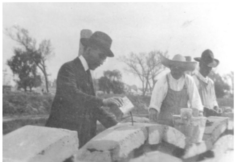
Trabajos en los remates en la parte superior de un edificio, probablemente el Cuadrilátero, ca. 1924 (imagen: AHC IPN, Fototeca).
