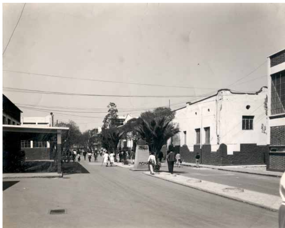
Vista desde la avenida Lázaro Cárdenas, la esquina suroeste del Cuadrilátero muestra la presencia de tres “claraboyas”, indicio de que en sus altísimos interiores se empezaron a usar tapancos para aprovechar mejor el espacio, ca. 1955 (imagen: AHC IPN, Fototeca).
