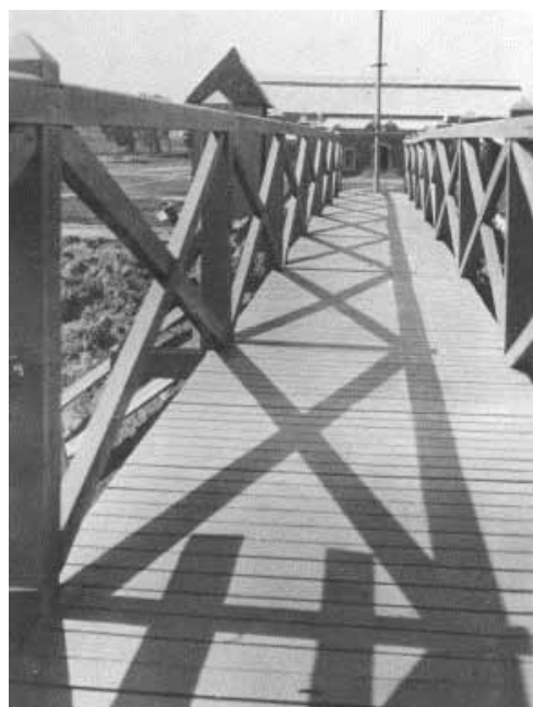
La pasadera de la calle de la Rosa; al fondo se identifican claramente los edificios D y B, ca. 1926 (imagen: AHC IPN, Fototeca).
