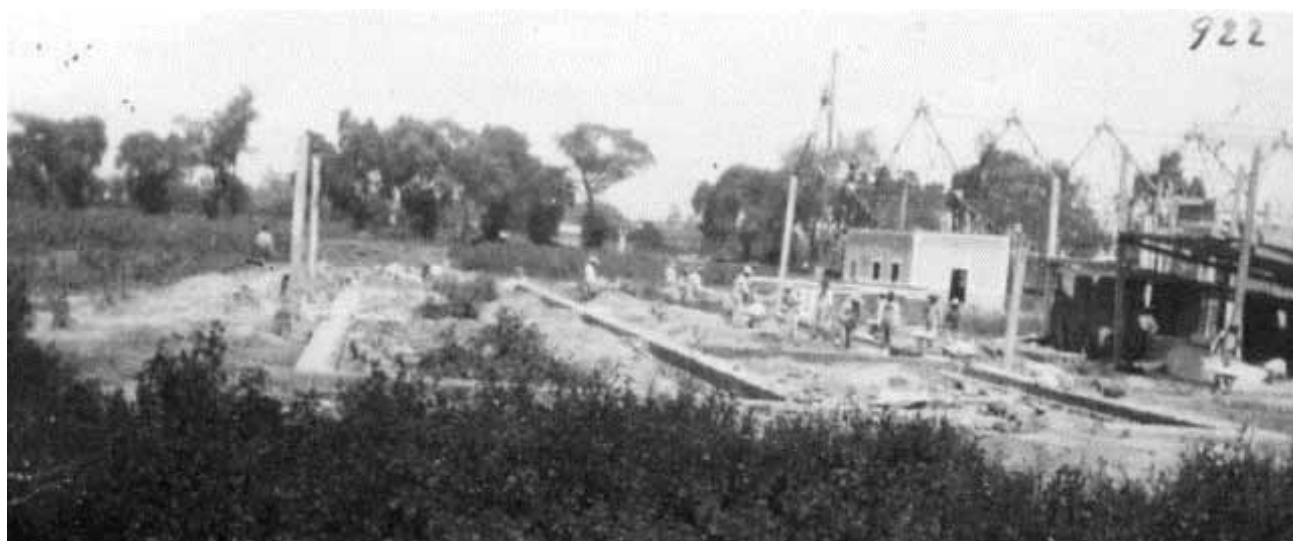
En esta toma fotográfica se aprecia la cimentación del edificio A vista desde el río Consulado, hacia el poniente. Del lado derecho pueden observarse las otras edificaciones, 1922 (imagen: AHC IPN, Fototeca).
