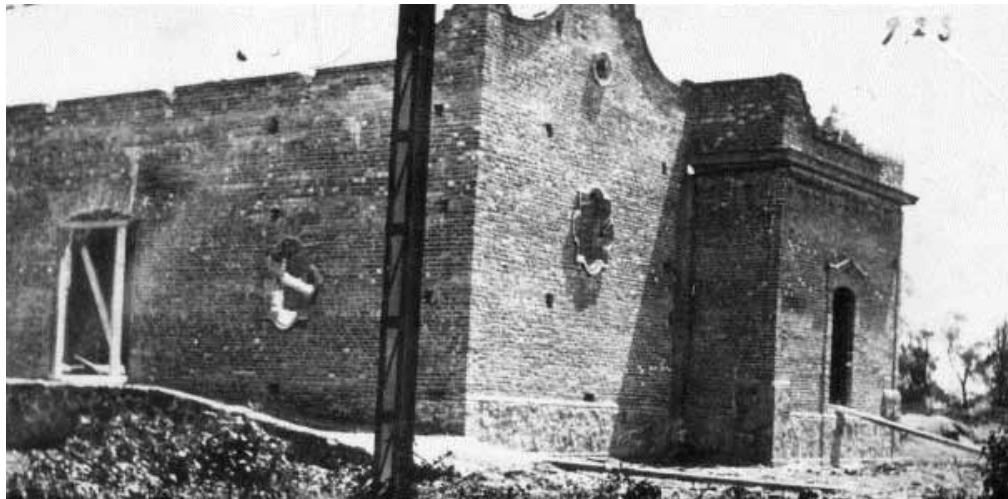
Construcción del edificio D, para la dirección de la ETF. Puede verse en el centro una columna de la nave de talleres y que el edificio se angostaba en la parte trasera, mientras que la colocación de remates, puertas y ventanas van definiendo el estilo arquitectónico, 1923 (imagen: AHC IPN, Fototeca).
