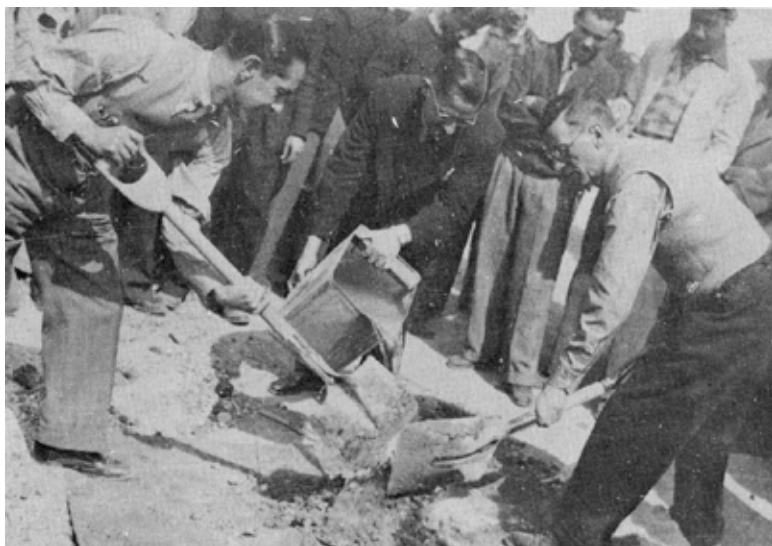
El ingeniero Wilfrido Massieu trabajó personalmente en la construcción de los edificios que alojarían la Escuela Técnica de Ferrocarrileros, ca. 1922 (imagen: AHC IPN, Fototeca).
