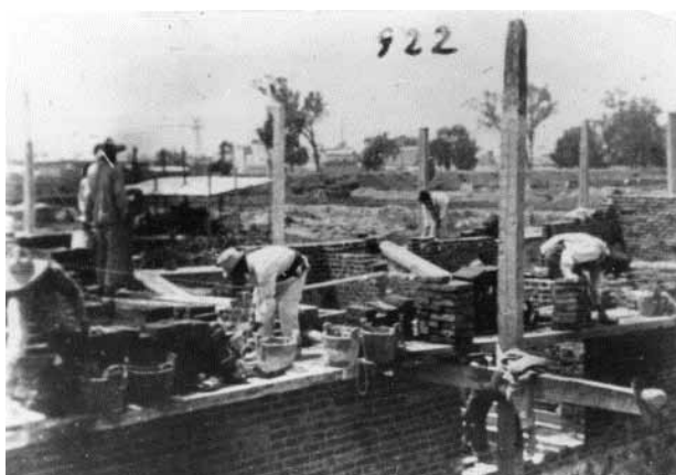
Obras del edificio D, 1922 (imágenes: AHC IPN, Fototeca).
