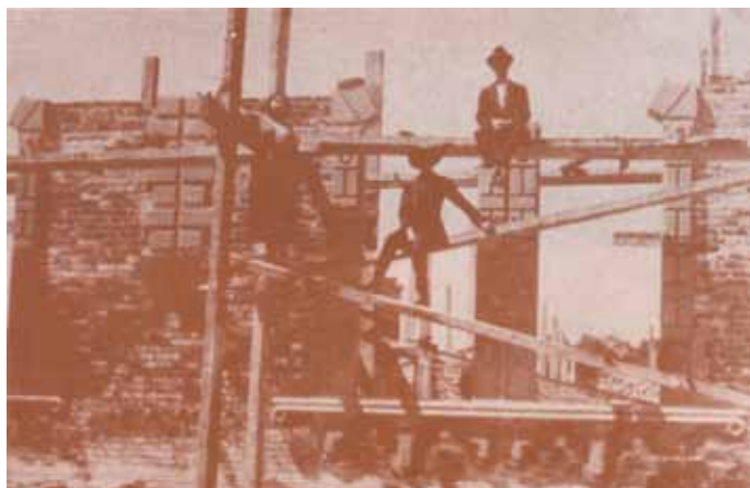
Contemplando las obras desde los andamios de la construcción del edificio D, ca. 1922 (imagen: AHC IPN, Fototeca).
