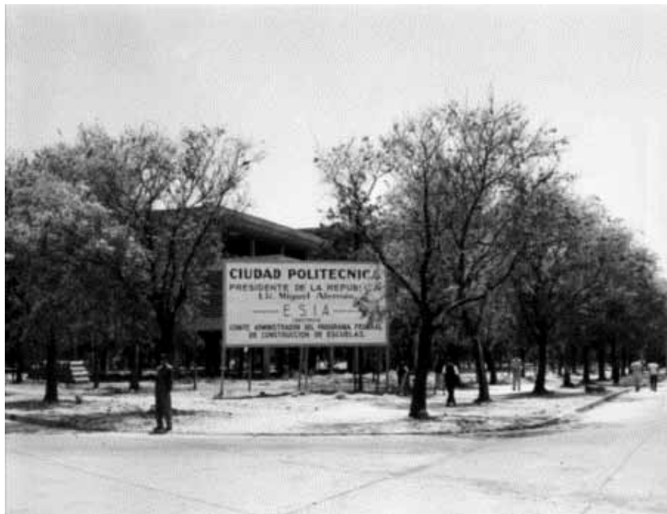
Construcción del edificio de la ESIA, en la esquina de Carpio y Plan de Ayala, ca. 1951 (imagen: AHC IPN, Fototeca).
