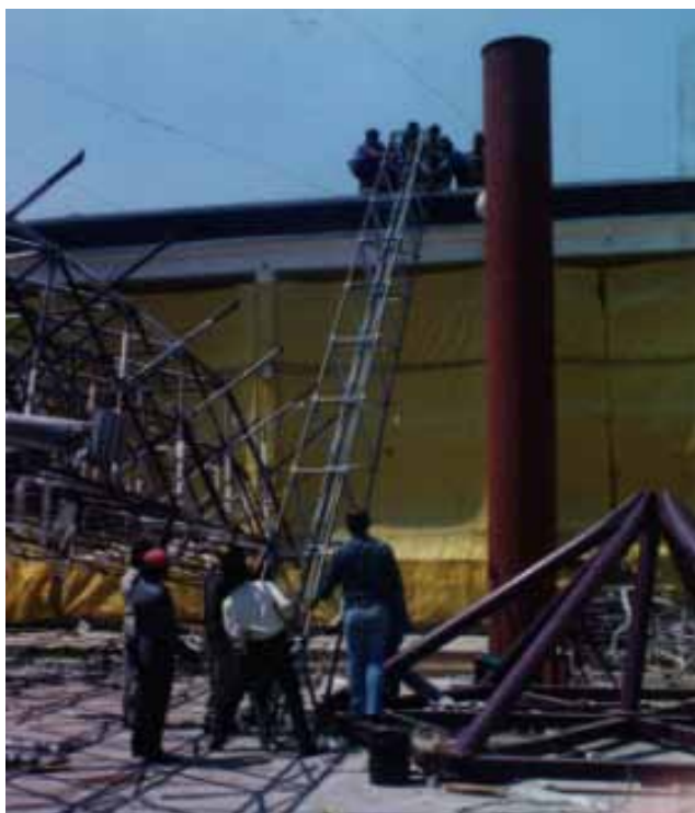
Ensamblaje y colocación del domo en el patio central, 1996 (imágenes: AHC IPN, Fototeca).
