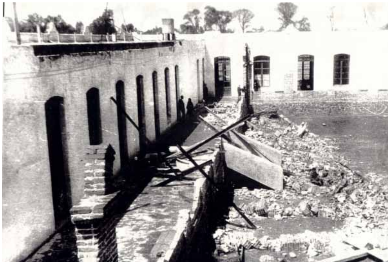
Los nueve arcos del ala sur dañados por el sismo, marzo de 1928 (imagen: AHC IPN, Fototeca).
