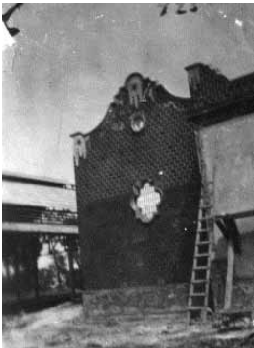
La ornamentación de la Dirección y, al fondo, la nave de talleres, 1923 (imagen: AHC IPN, Fototeca).
