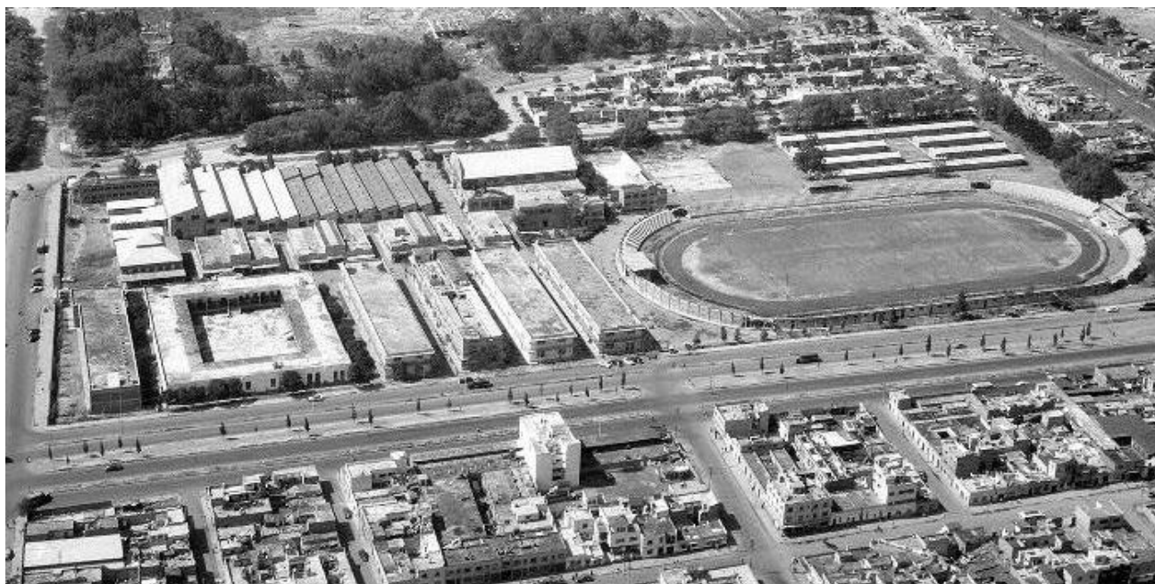
Los siete laboratorios frente al Cuadrilátero se convirtieron en cuatro, al construirse ampliaciones en los pasillos entre los primeros seis, con dos pisos, 1952 (imagen: Fundación ICA, Fondo Aerofotográfico).
