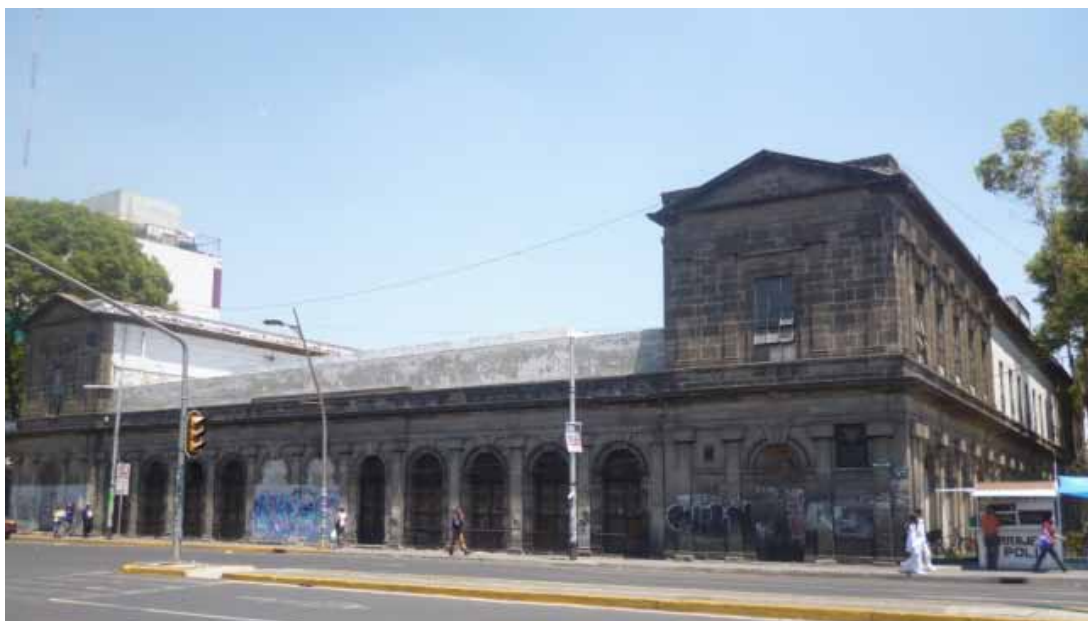
Edificio de la antigua Escuela Nacional de Agricultura y Veterinaria, en San Jacinto; tras la salida de ésta, fue ocupado sucesivamente por la Escuela Nacional de Maestros, la Escuela Superior de Construcción, una secundaria y actualmente forma parte del patrimonio de la UNAM, 2014 (imagen: Departamento de Investigación Histórica).
