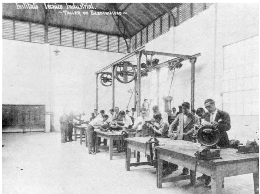
Taller de electricidad, en el edificio E, 1926 (imagen: AHC IPN, Fototeca, Colección Miguel Bernard).
