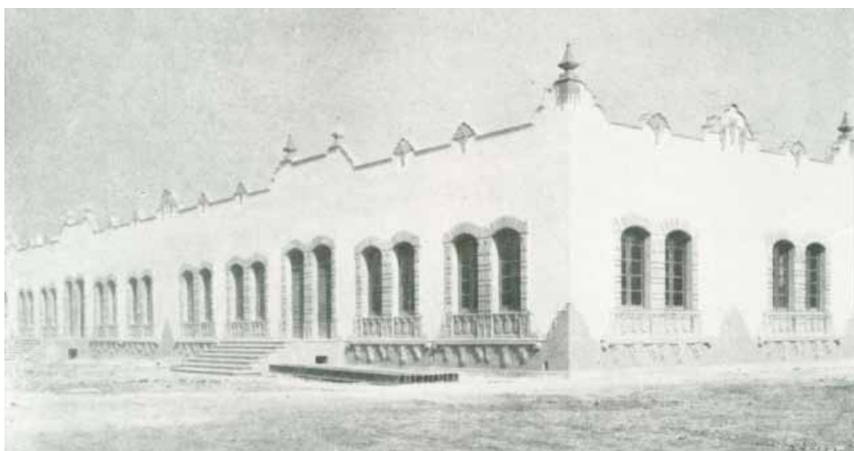
Una esquina del edificio A concluido, ca. 1926 (imagen: AHC IPN, Fototeca).
