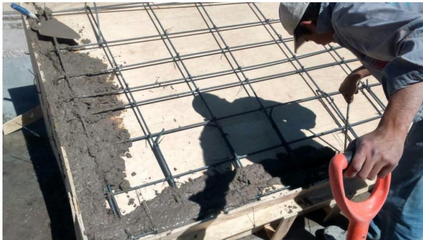
**Figura 15.** Vertimiento de concreto con  $F'c=250 \text{ kg/cm}^2$  en la estructura del reactor.
