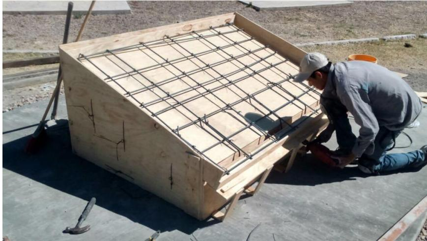
**Figura 14.** Cimbrado de la estructura para el reactor de concreto.
