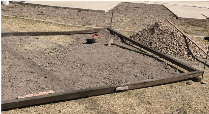
**Figura 11.** Delimitación del área del firme ( $16\text{m}^2$ ) con madera de pino.
