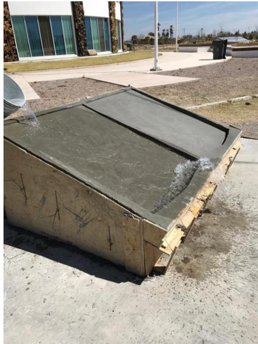
**Figura 16.** Curado final del concreto de la estructura del reactor.
