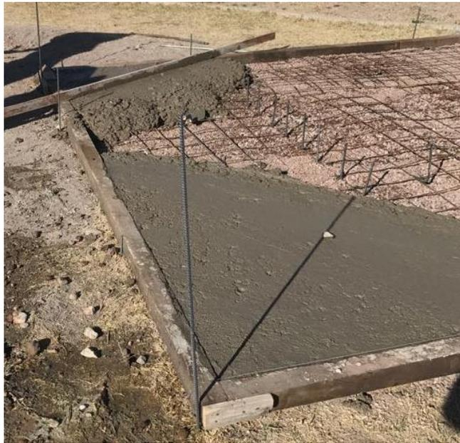
**Figura 13.** Vertimiento del concreto con  $f'c=100 \text{ kg/cm}^2$  para el firme.
