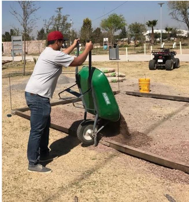
**Figura 12.** Nivelación del terreno del área del filme.
