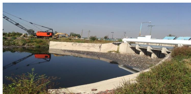
Fig. 10 Entrada al proceso de tratamiento por Lagunas de estabilización u oxidación.
