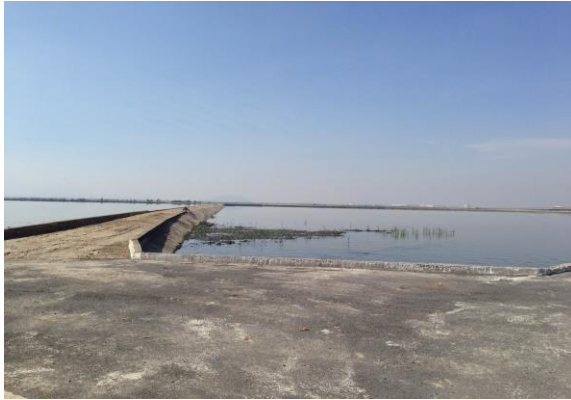
Fig. 11 Lagunas de estabilización.
