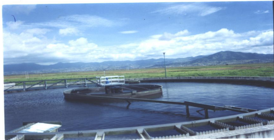
Fig. 15 Tanque de sedimentación primaria de forma circular.
