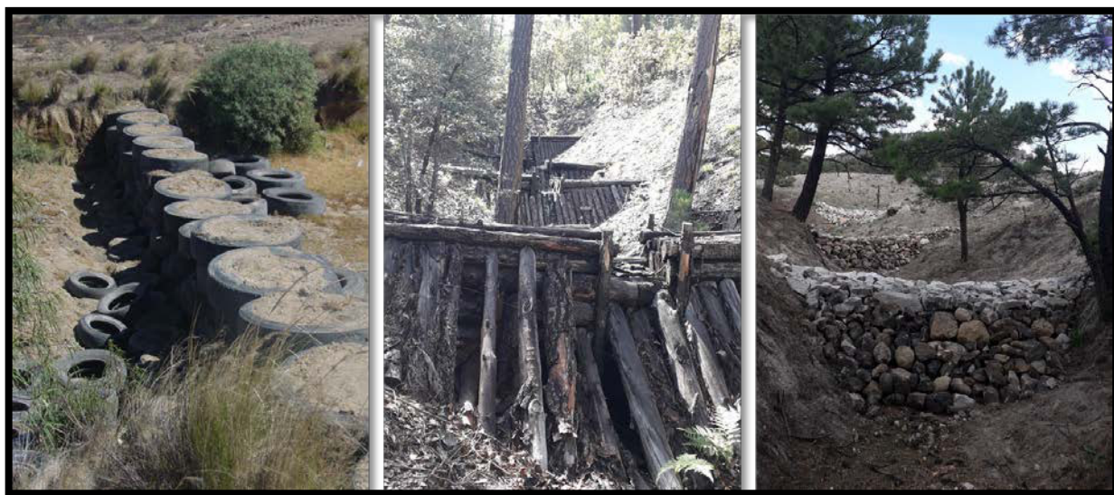
Figura 2. Presas filtrantes de llantas, morillos de madera y piedra.
