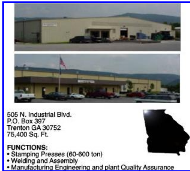
Figura 9. Ubicación de las instalaciones de Gill Trenton.
