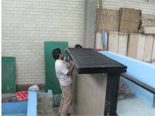
**Figura 39. Colocación del amortiguador.**
