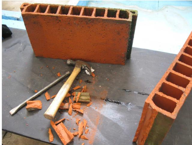
**Figura 40. Corte de bovedillas.**
