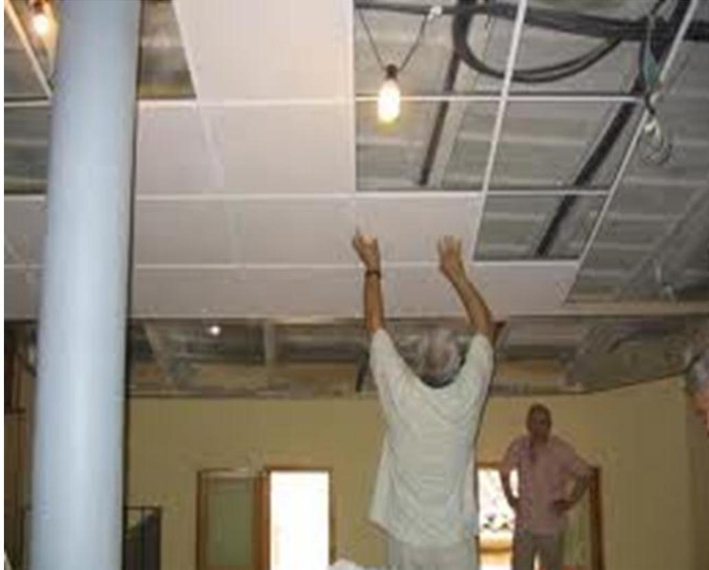
Decidimos utilizar el techo falso porque si llega a ver un problema de inundación, con el techo no tendríamos problemas. Nuestro techo falso lo constituiremos mediante piezas o elementos en estado de prefabricación y por medio de la escayola.
