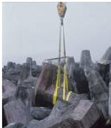
**Figura 2.11 Colocación del dolo en la obra de protección.**
