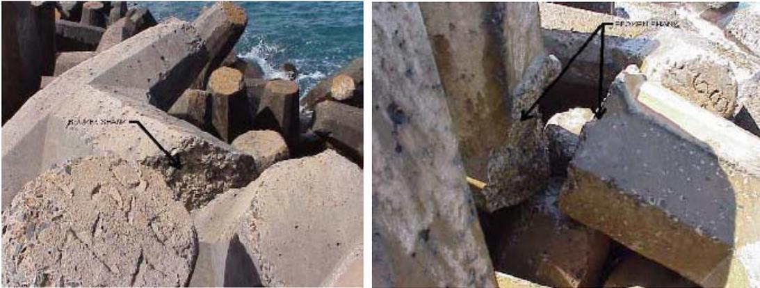
**Figura 8.5 y 8.6 Fractura y rompimiento de los brazos de los dolos.**
