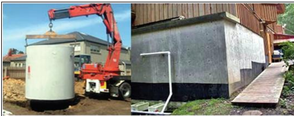
Figura 4.19 Tanque de concreto.
