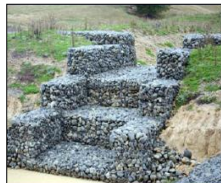
Figura 2.21 Dique con gaviones. Fuente: CATIE Turrialba, Costa Rica, 2006.
