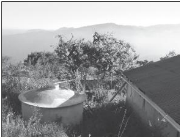
Figura 4.25 Tanque cilíndrico de ferrocemento.
