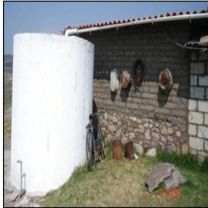
Figura 4.18 Tanque de ferrocemento.
