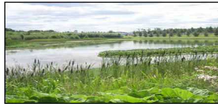
Figura 2.37 Estanque de retención.
