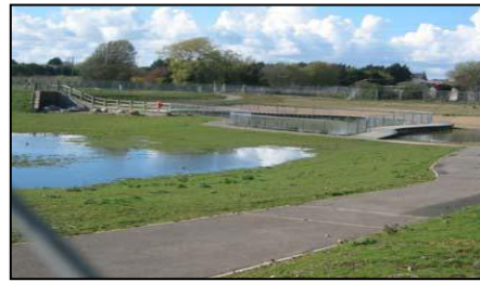
Figura 2.35 Depósitos de infiltración.
