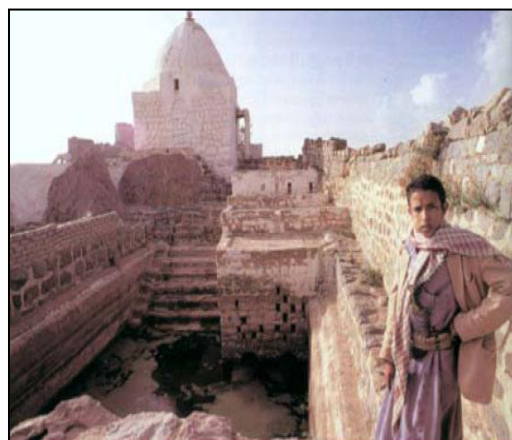
Figura 2.3 Cisterna a cielo abierto para la recolección de agua lluvia en la República de Yemen.
