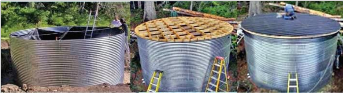
Figura 4.21 Cisterna de metal.
