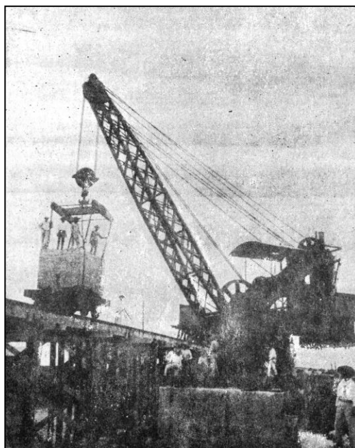
Ilustración 1-11 Proceso constructivo del Malecón del puerto de Veracruz mediante bloques de concreto premezclado de 30 ton de peso. 13
