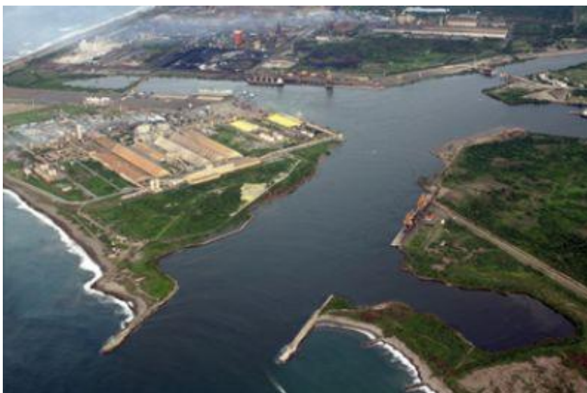
Ilustración 3-51 Acceso al Puerto de Lázaro Cárdenas.
