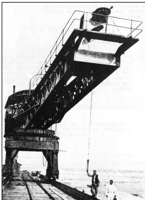
Ilustración 1-12 Grúa “Titán” utilizada para la colocación de bloques de concreto en la secciones de los rompeolas noreste y sureste. 14
