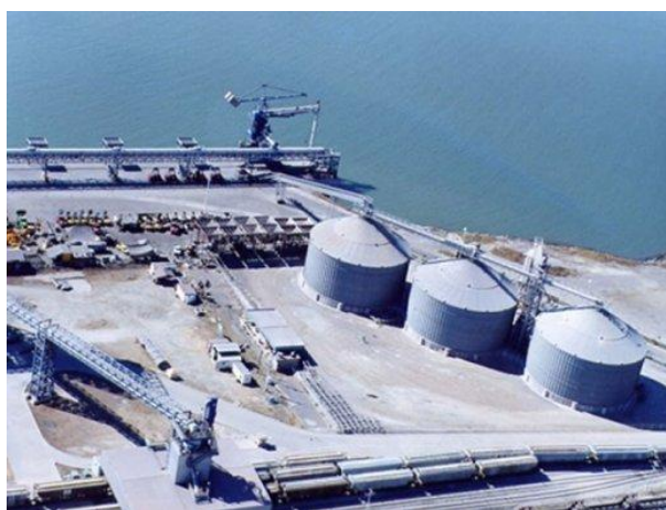
Ilustración 3-50 Silos de Almacenamiento del Puerto de Manzanillo.
