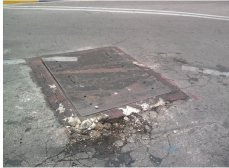
**Figura 4.7.- Desprendimiento de Material**
