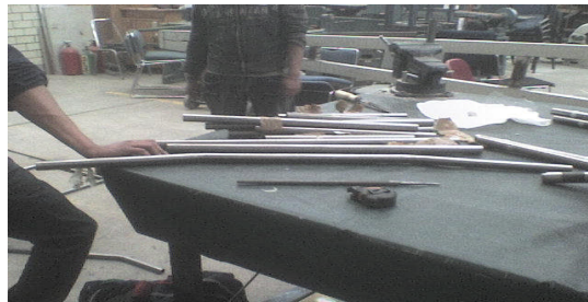
Figura 17- Doblado, Cortado y Ensamble de la tubería
