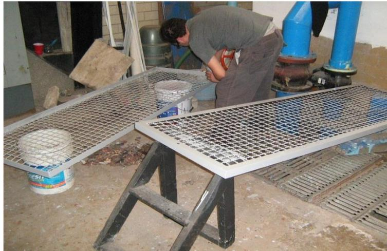
Fig.5.8. Mantenimiento del amortiguador de oleaje.
