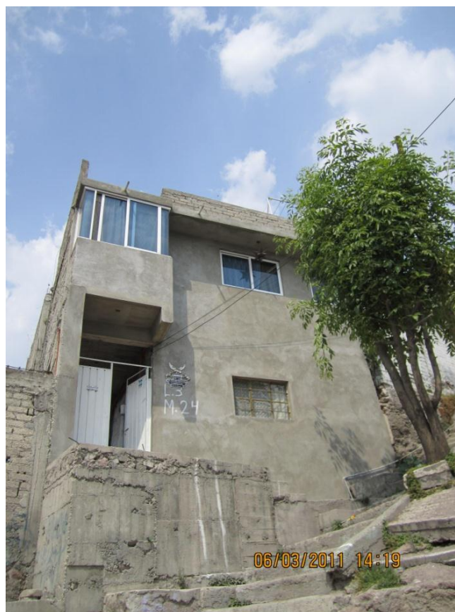
FOTOGRAFÍA No. 46: VIVIENDA POPULAR TERMINADA.
