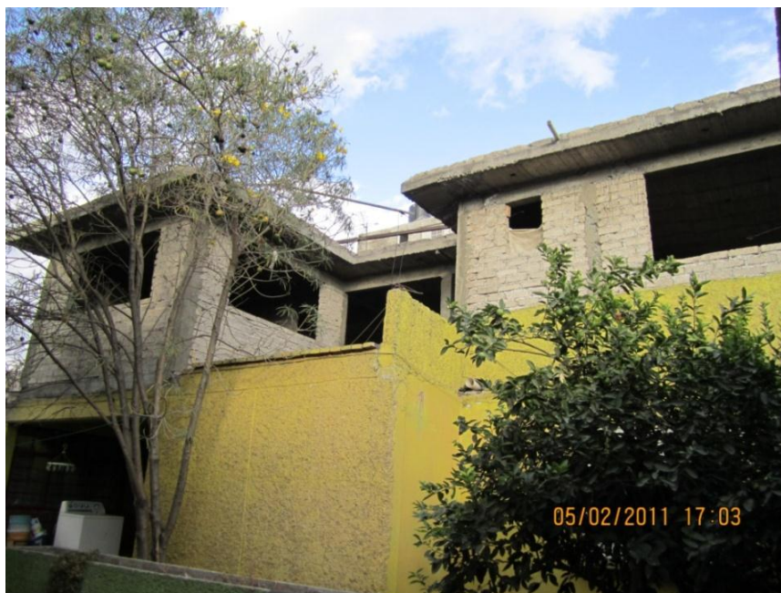
FOTOGRAFÍA No. 40. CONSTRUCCIÓN DE VIVIENDA NUEVA PROGRESIVA.
