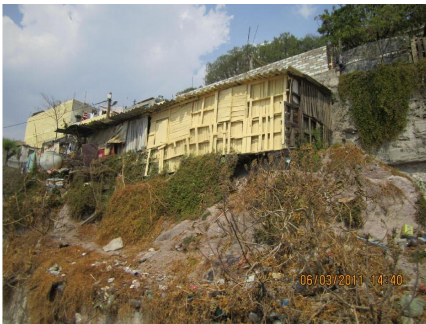
FOTOGRAFÍA No. 8. VIVIENDA PRECARIA.
