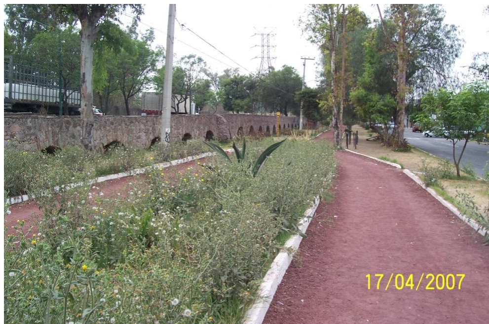
FOTOGRAFÍA No. 19. ACUEDUCTO TLALNEPANTLA-VILLA DE GUADALUPE.
