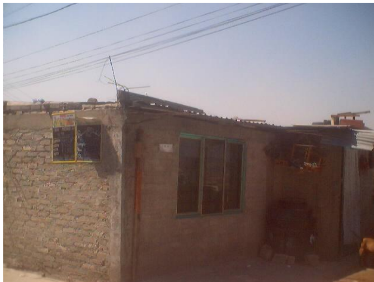
FOTOGRAFÍA No. 3. MEJORAMIENTO DE VIVIENDA.
