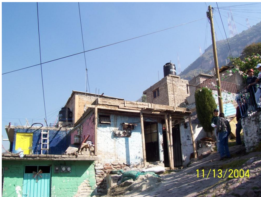
FOTOGRAFÍA No. 23. VIVIENDA ANTES DE LA INTERVENCIÓN DEL PROGRAMA.
