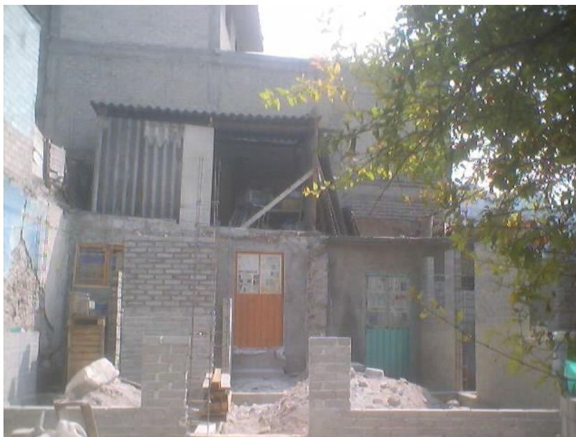
FOTOGRAFÍA No. 1. INICIO DE AMPLIACIÓN DE LA VIVIENDA.
