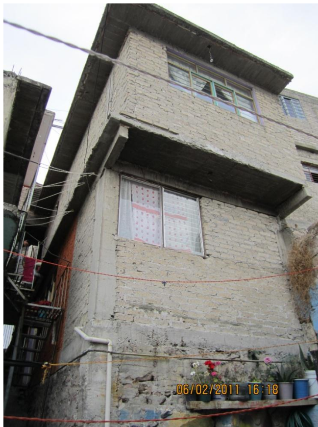
FOTOGRAFÍA No. 38. VIVIENDA NUEVA PROGRESIVA.
