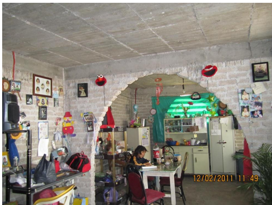
FOTOGRAFÍA No. 36. VIVIENDA HABITADA AÚN SIN ACABADOS Y CANCELERÍA.
