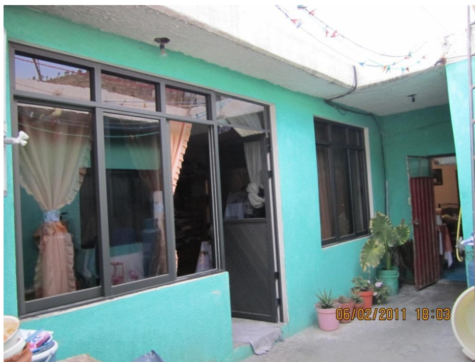
FOTOGRAFÍA No. 41. CONSTRUCCIÓN DE TRES ESPACIOS NUEVOS A LA VIVIENDA.
