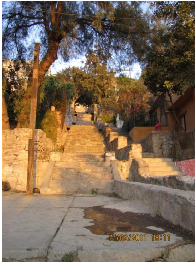
FOTOGRAFÍA No. 22: CALLE PEATONAL DE IZTACCIHUATL.
