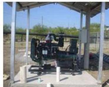
PRODUCCIÓN DE ENERGÍA ELÉCTRICA A TRAVÉS DE BIOGAS.
