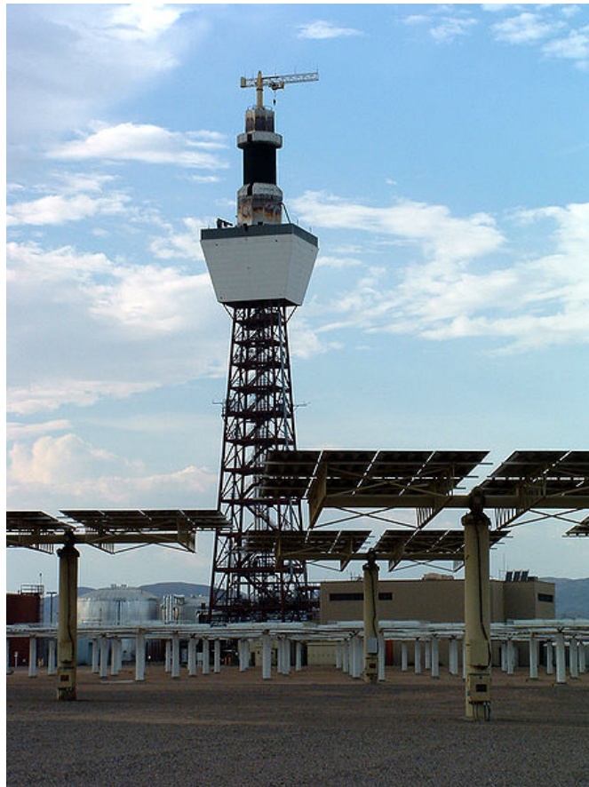
Antigua central térmica solar (Solar Two) en Barstow, CA. Hoy observatorio astronómico para contemplar la Radiación de Cherenkov.
