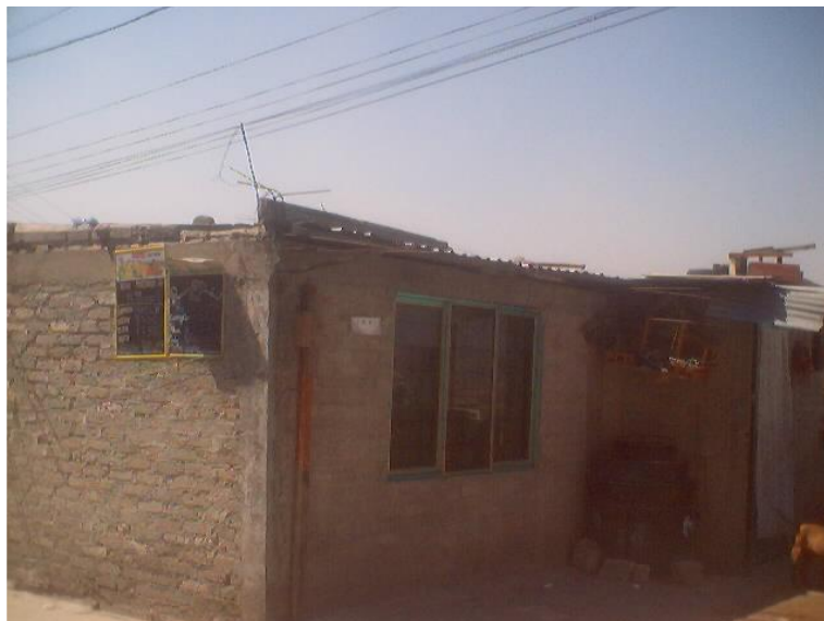
FOTOGRAFÍA No. 3. MEJORAMIENTO DE VIVIENDA.
