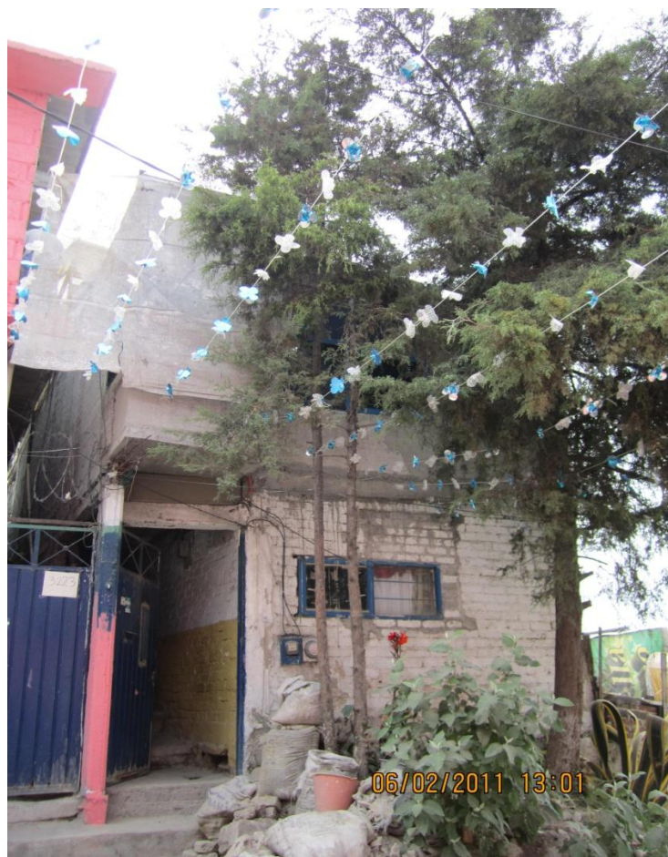
FOTOGRAFÍA No. 5. MEJORAMIENTO Y AMPLIACIÓN DE VIVIENDA.
