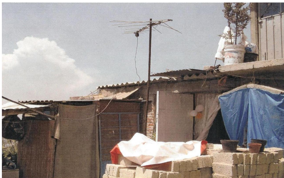
FOTOGRAFÍA No. 47. VIVIENDA PRECARIA EN EL AÑO 2004, CASO No. 52.
