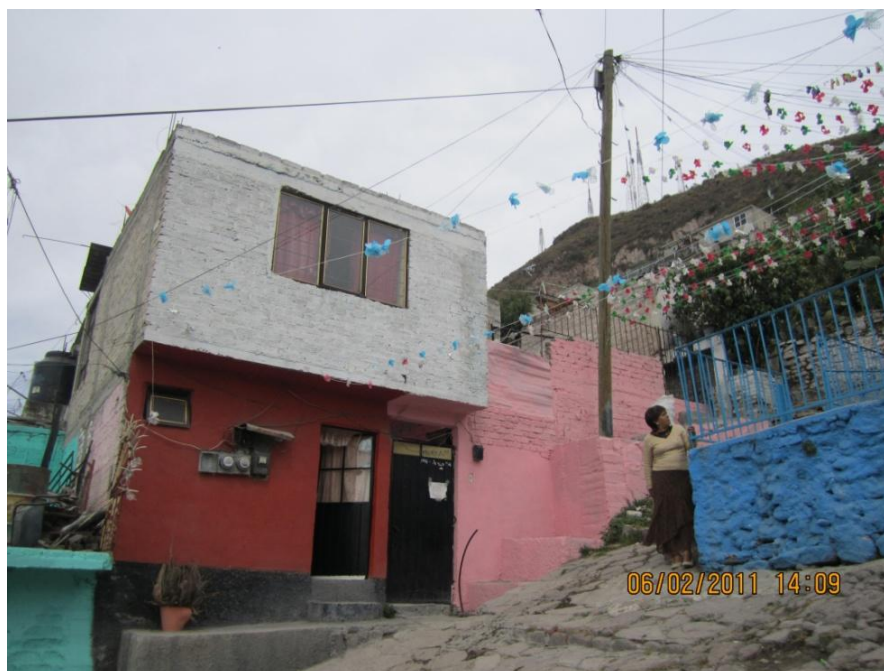
FOTOGRAFÍA No. 25. ESTADO ACTUAL DE LA VIVIENDA, CASO NO. 9.
