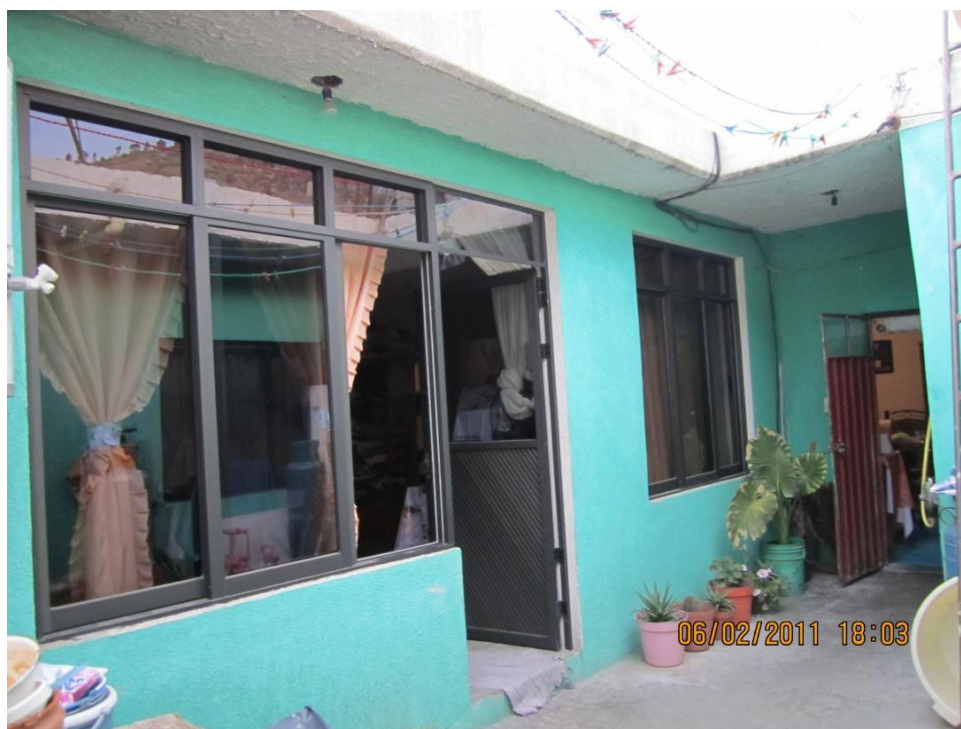
FOTOGRAFÍA No. 41. CONSTRUCCIÓN DE TRES ESPACIOS NUEVOS A LA VIVIENDA.
