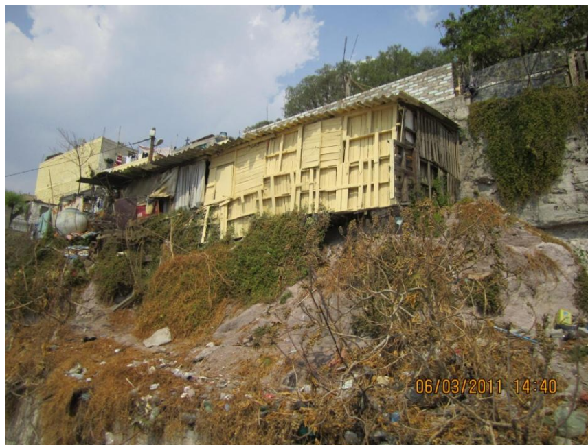
FOTOGRAFÍA No. 8. VIVIENDA PRECARIA.
