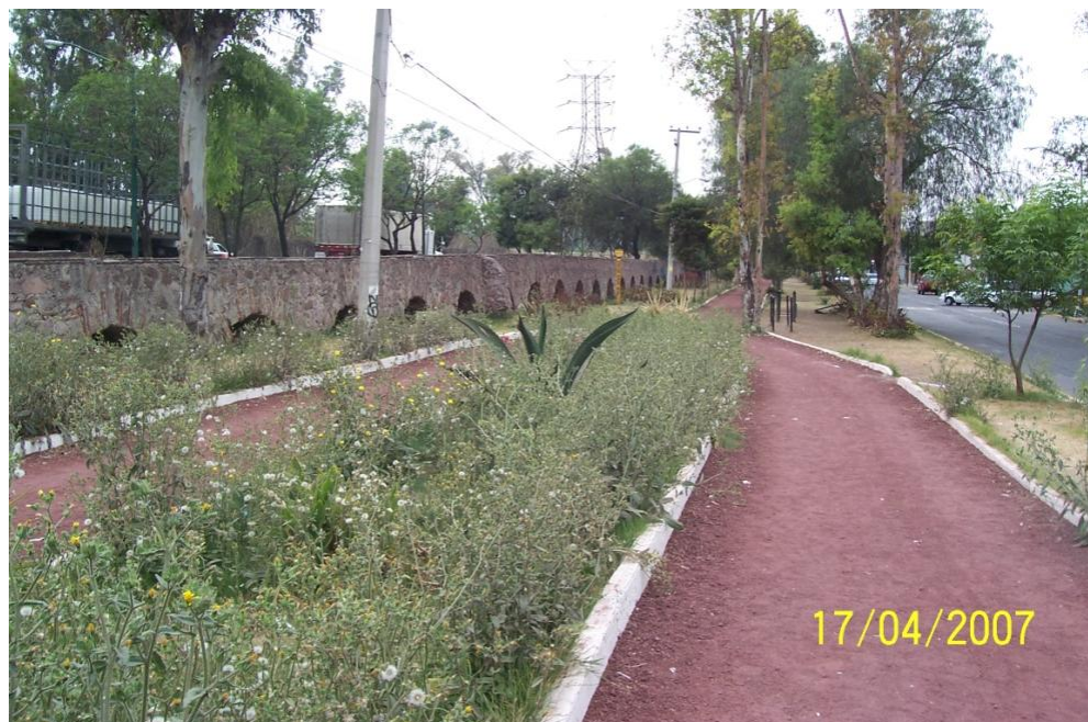
FOTOGRAFÍA No. 19. ACUEDUCTO TLALNEPANTLA-VILLA DE GUADALUPE.
