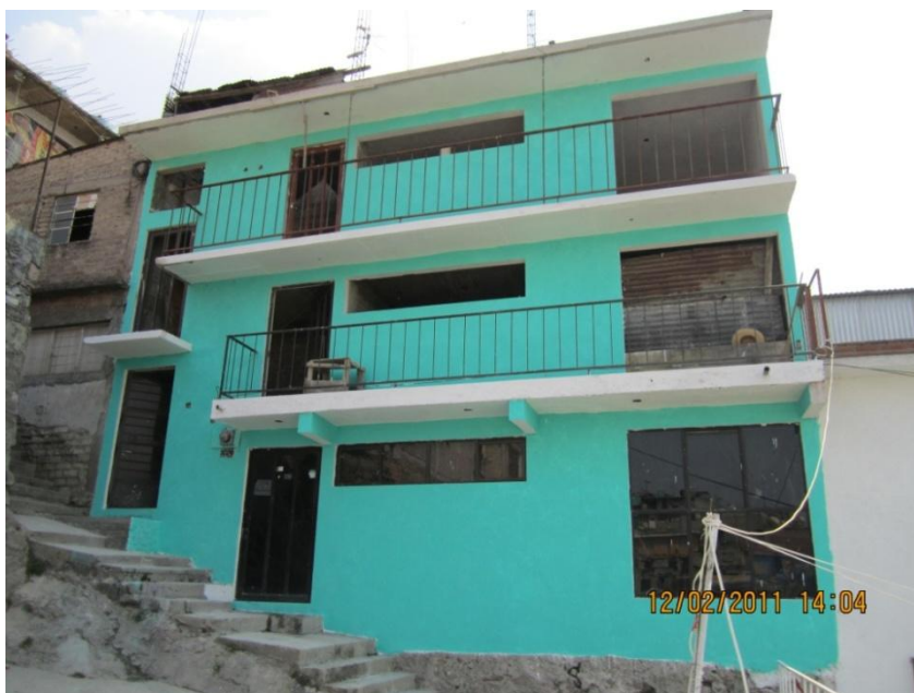
FOTOGRAFÍA No. 33. CONSOLIDACIÓN DE LAS VIVIENDAS EN CONJUNTO.
