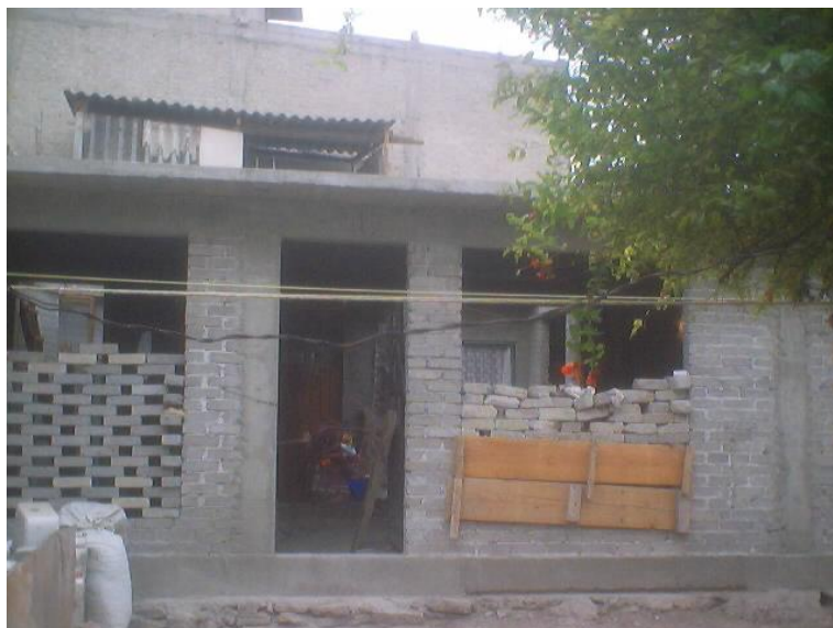
FOTOGRAFÍA No. 2. TERMINACIÓN DE LA AMPLIACIÓN DE VIVIENDA.
