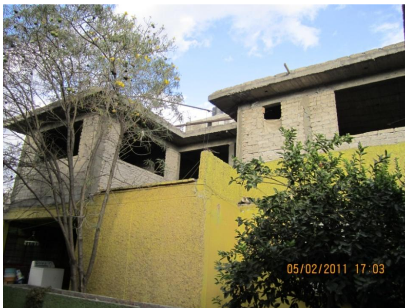
FOTOGRAFÍA No. 40. CONSTRUCCIÓN DE VIVIENDA NUEVA PROGRESIVA.
