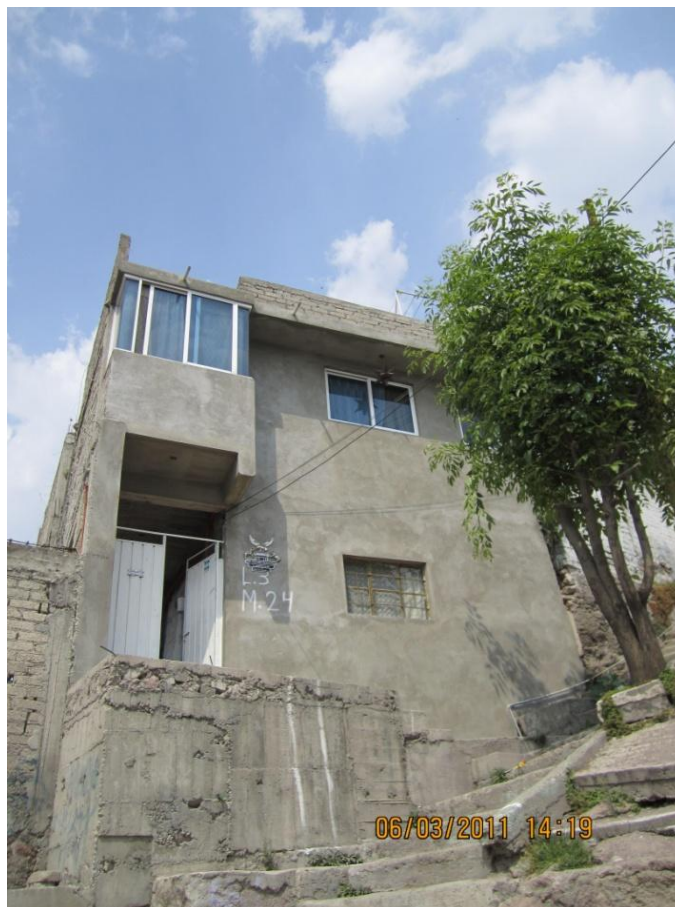
FOTOGRAFÍA No. 46: VIVIENDA POPULAR TERMINADA.
