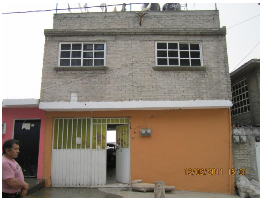
FOTOGRAFÍA No. 39. VIVIENDA NUEVA SOBRE LOSA DE AZOTEA.
