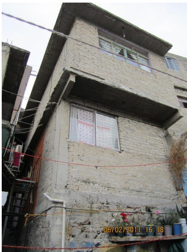
FOTOGRAFÍA No. 38. VIVIENDA NUEVA PROGRESIVA.
