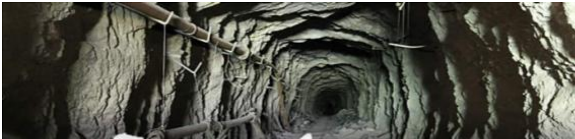
Imagen 1.- Túnel sin recubrimiento (minero)
