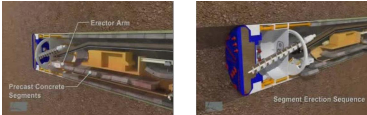
Imagen 9.-Transporte de dovelas (izq), colocación de primer dovela (der)
