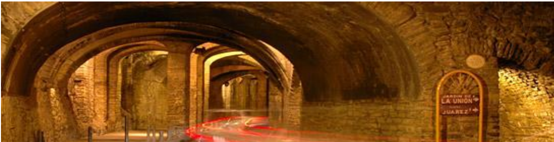
Imagen 2.- Túnel con recubrimiento (vehicular)
