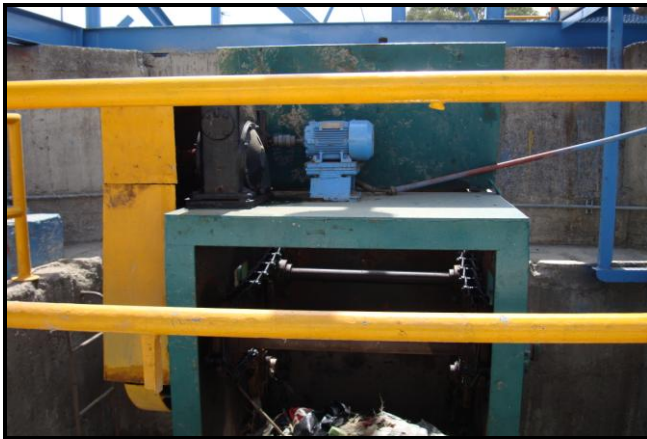
Figura II.3.1 Sistema de rejillas en obra de toma
