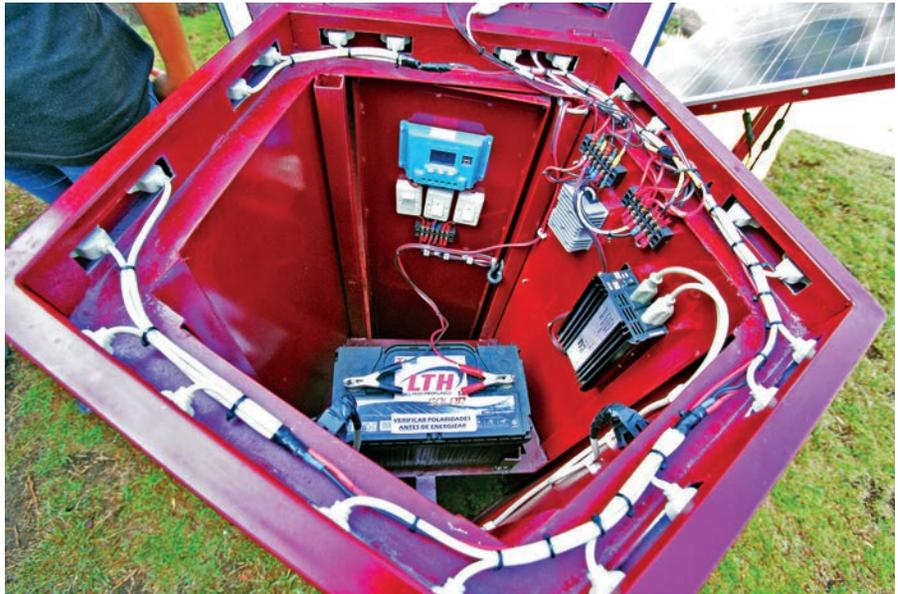
El Centro de Carga Solar suministra batería a dispositivos electrónicos a partir de la generación de energías verdes. (Fotos: Octavio Grijalva)
