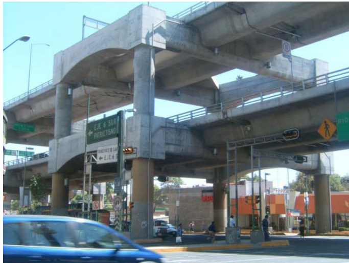
Figura 2.9 Configuración transversal tipo marco dos niveles.
