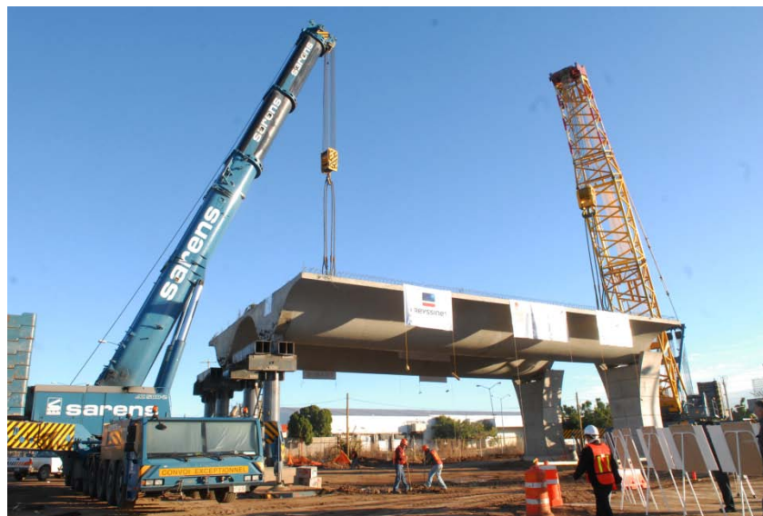
Figura 2.19 Trabe central tipo cajón.
