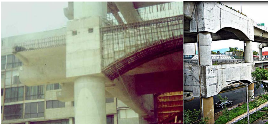
Figura 2.17 Armado de trabe de rigidez primer nivel.
