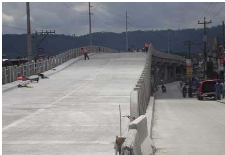
Figura 2.21 Acabado final en distribuidor vial.
