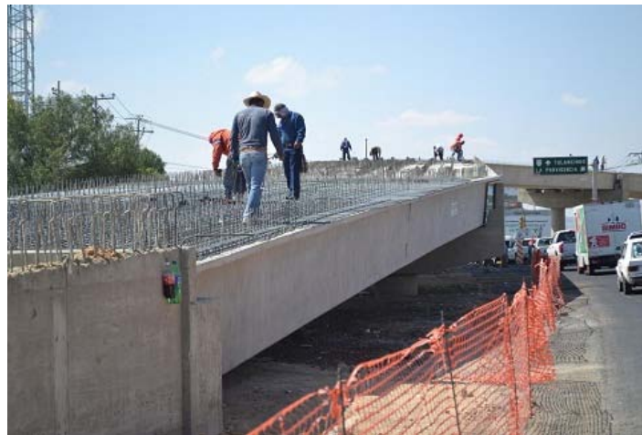
Figura 2.20 Armado de firme estructural.
