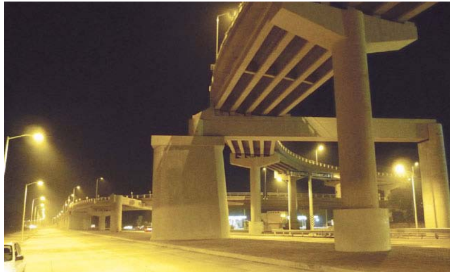
Figura 2.18 Perspectiva de una trabe de apoyo.
