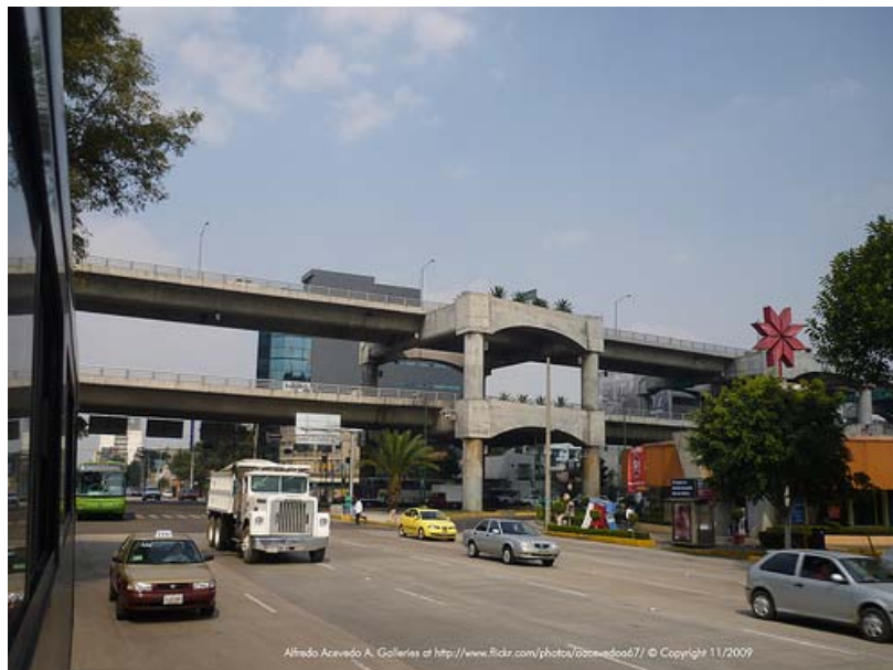
Figura 2.10 Configuración longitudinal tipo marco dos niveles.
