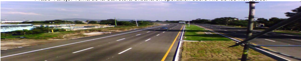
Fotografía 1 Prado Vallejo. Toma de la Carretera Urbana en operación sobre Río de los Remedios.
