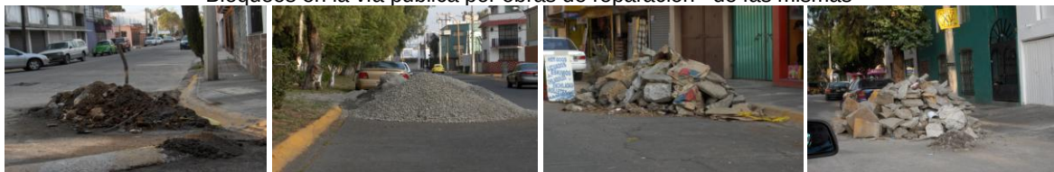
Fotografía 25 Bloqueos en la vía pública por obras de reparación de las mismas
