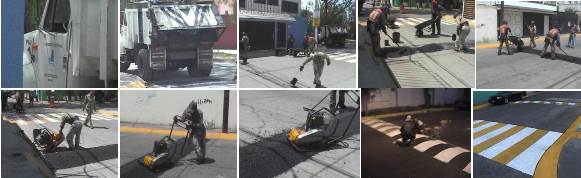
Fotografía 35 Elaboración de un tope por el personal del Municipio de Tlalnepantla de Baz
