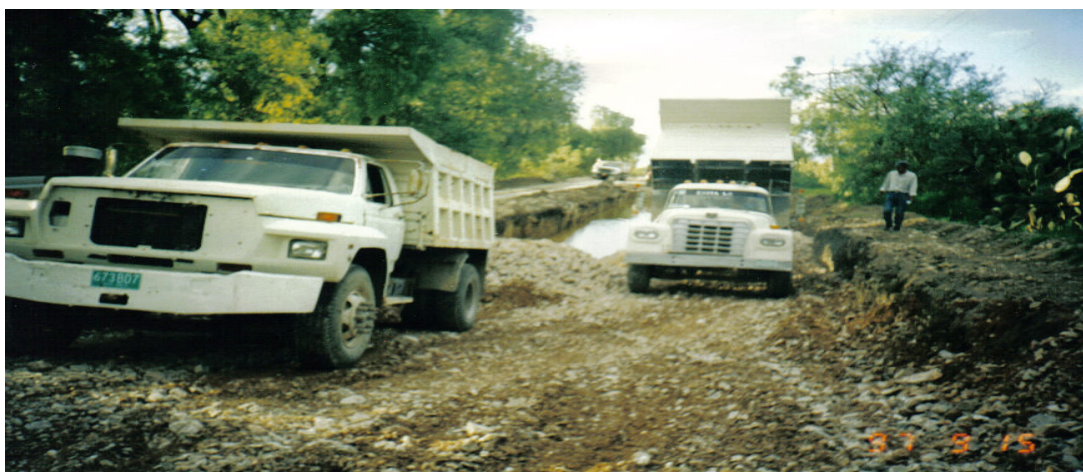
Ilustración No. VI.34. Acarreo y colocación de material para piedraplen.
