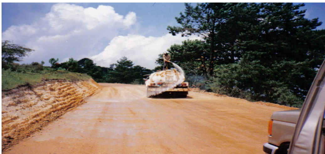
Ilustración No. VII.3. Humedad óptima en la capa de subrasante.
