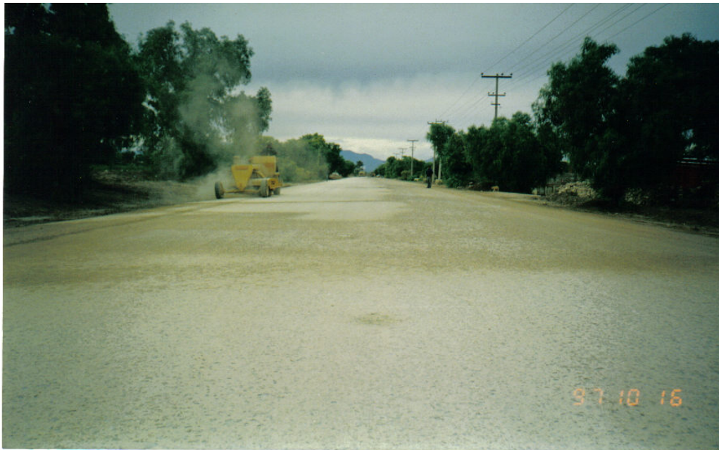
Ilustración No. IV. 12. Barredora mecánica; barriendo base hidráulica antes de aplicar el riego de impregnación.
