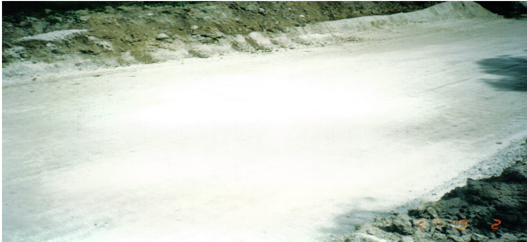
Ilustración No.VI.42. Capa de capilaridad formada con cal sobre piedraplen para evitar corriente de fluidos y el arrastre de finos.
