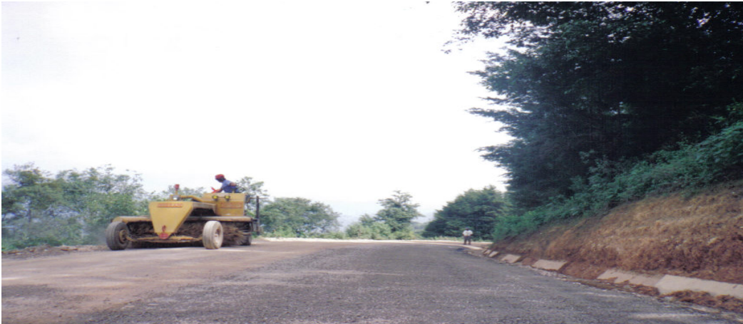
Ilustración No. VII.10. Barrido mecánico de la base.
