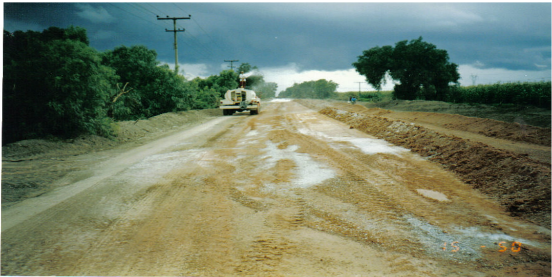
Ilustración No.VI.5. Humedeciendo materiales de las terracerías a través del camión pipa con motobomba.
