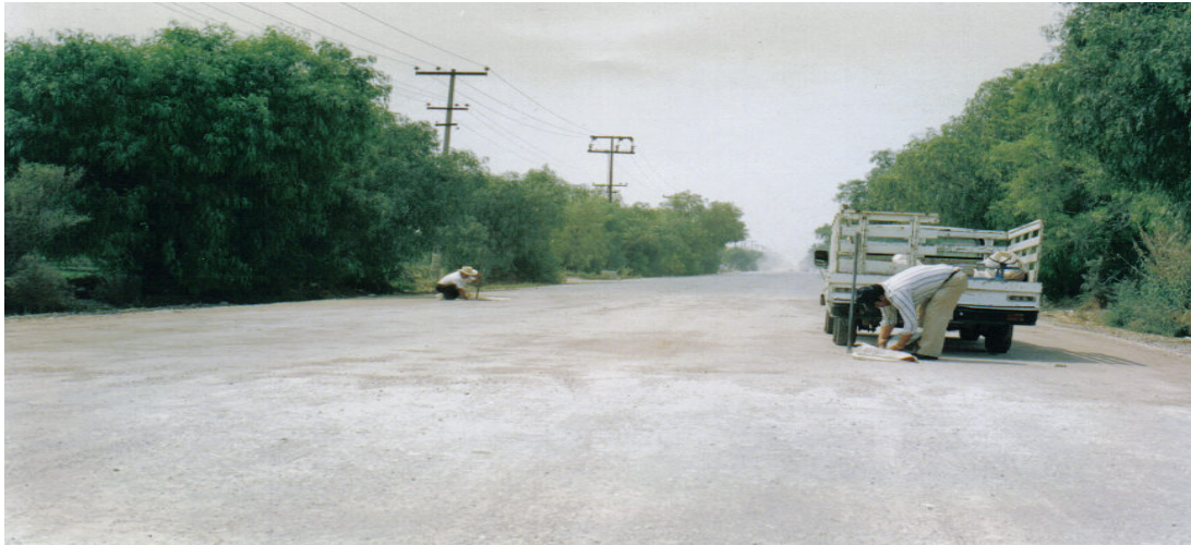
No. VI.29. Laboratorio levantando muestras para compactaciones.
