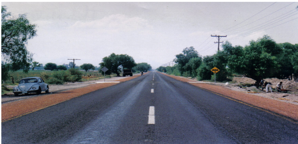
Ilustración No. VI. 20. Riego de sello negro sobre carpeta y sello rojo en ambos hombros en acotamientos.
