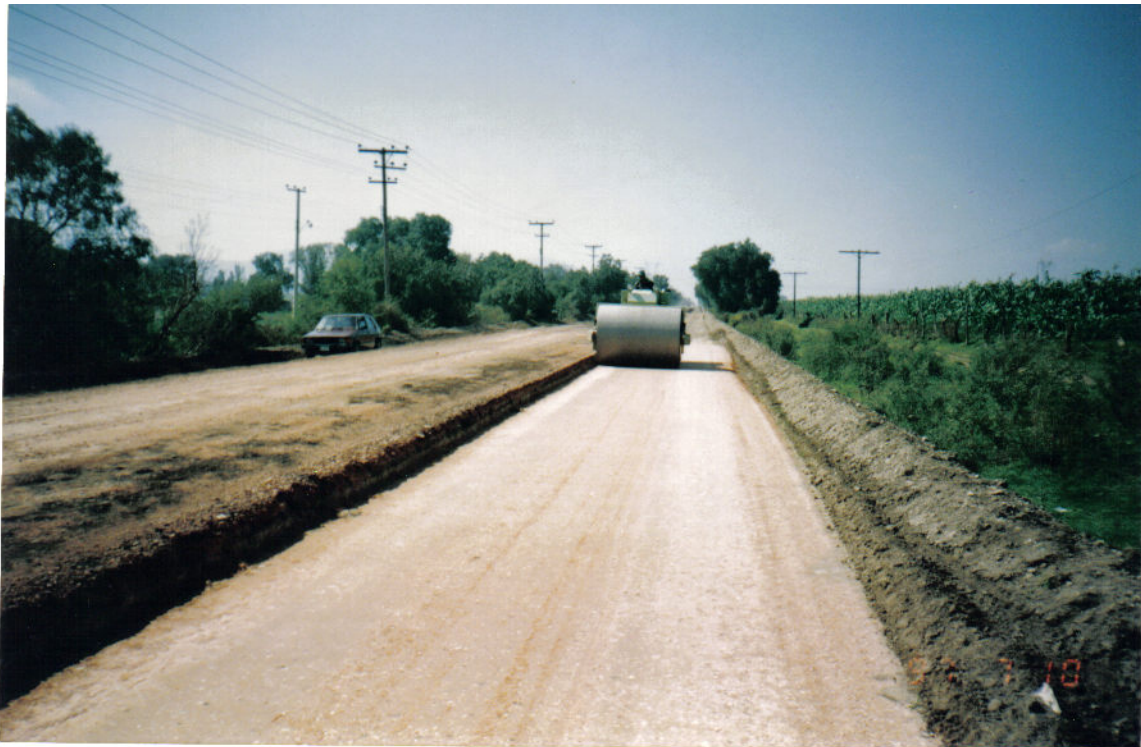
Ilustración No. VI.4. Compactación de la capa de subrasante en los hombros de la ampliación.
