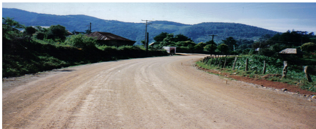
Ilustración No. VII. 7. Capa de base hidráulica.
