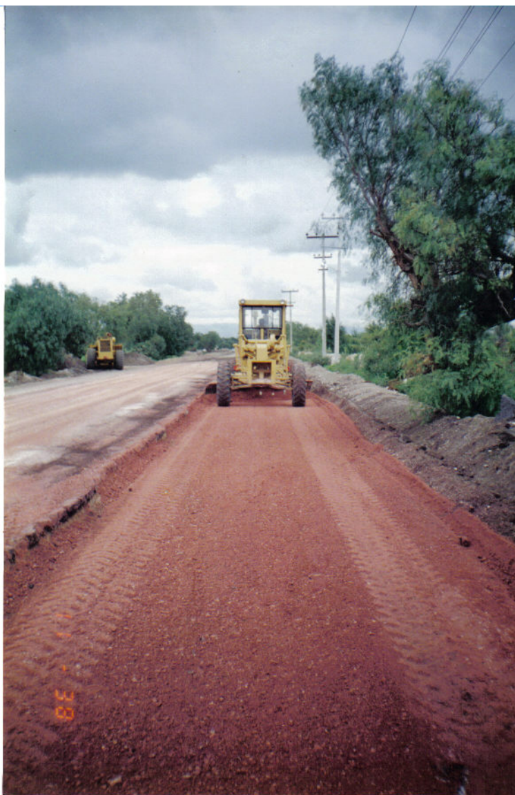
Ilustración No. VI.3. Tendido del material para subrasante en uno de los hombros del camino con la motoconformadora.
