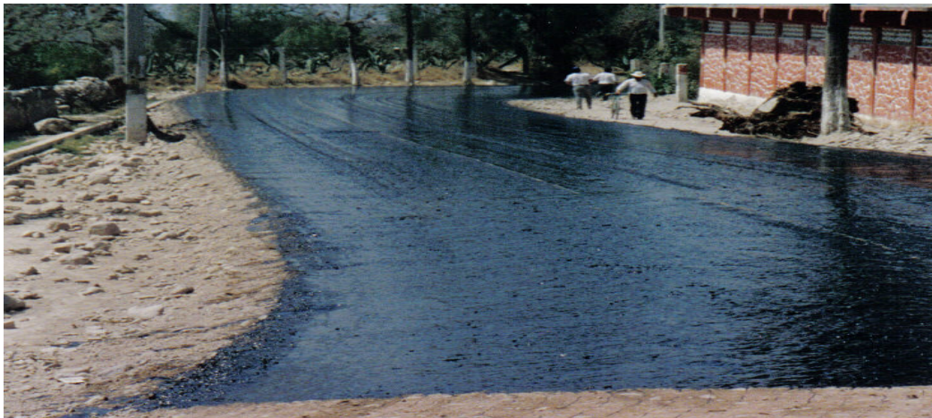
Ilustración No. VII.11. Riego de impregnación.
