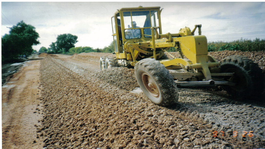
Ilustración No.IV.7. Motoconformadora mezclando los materiales que constituyen las diferentes capas del pavimento.
