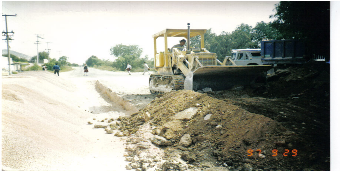
Ilustración No. IV.2. Traxcavo o cargador montado sobre orugas realizando cortes y acumulación de materiales para su posterior descarga en volteos.
