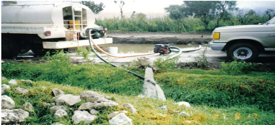
Ilustración No.VI.41. Abatimiento o achique del agua con motobomba de la falla geológica.
