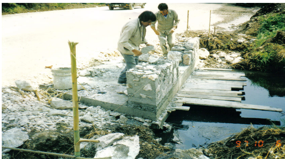
Ilustración. No.VI.26. Proceso constructivo de cabezotes de mampostería en la ampliación de las alcantarillas en las obras de drenaje.
