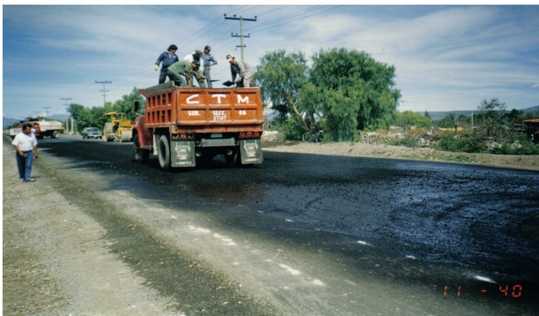
Ilustración No. VI.16. Realizando manto con mezcla asfáltica sobre el riego de liga para recibir la carpeta asfáltica.
