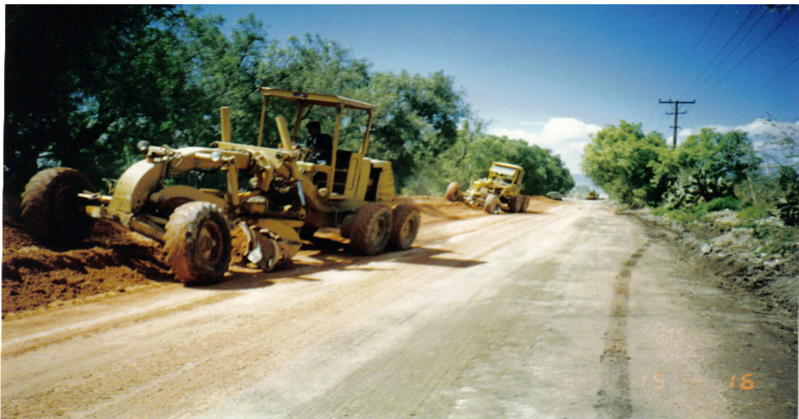
Ilustración No.VI. 8. Mezclado del material con incorporación de agua.
