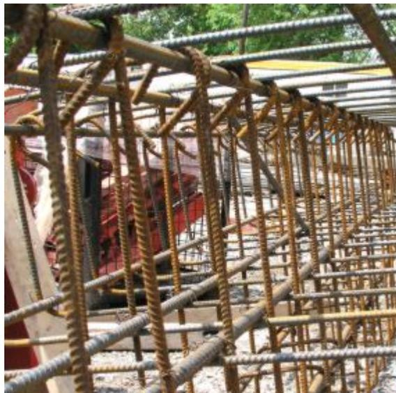
Fig.4.3 Armaduras antes del armado.
