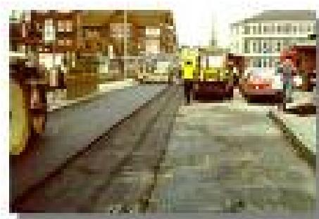
Fig. 4.1 Aplicación de las mezclas asfálticas
