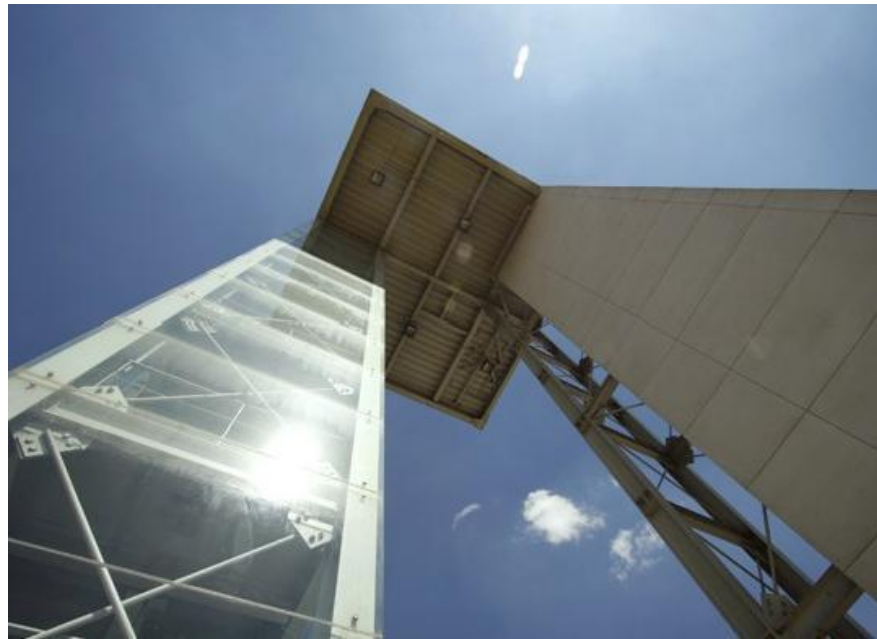
Fig. 4.1.- Nueva Torre de Control.
