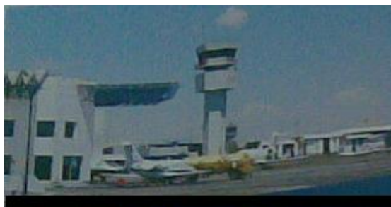
Fig. 2.5.- Antigua Torre de Control.
