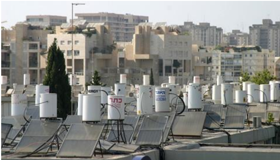
Fig. 25 Calentadores Solares de Agua (Chipre e Israel).
