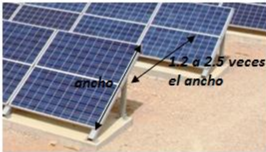
Fig. 48 Distancia entre paneles, mínima y máxima para la Ciudad de México.
